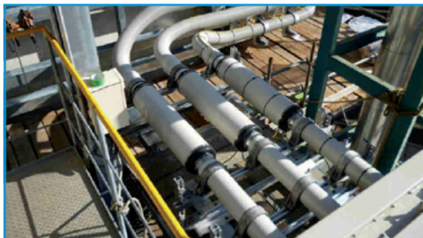
Figura 1 - esempio di installazione Sistema IPB (Isolated Phase Bus) – fonte: Duresca ® Bus bar system (Moser Glaser)
