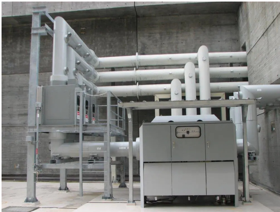
Figura 3 - esempio di installazione Sistema IPB (Isolated Phase Bus)
