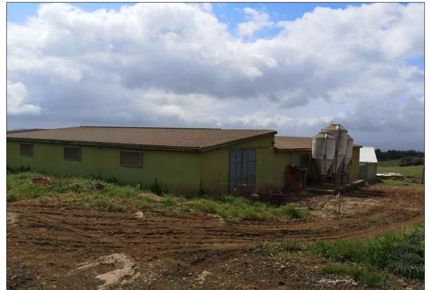
Foto Recettore R29 - Prospetto angolo frontale
