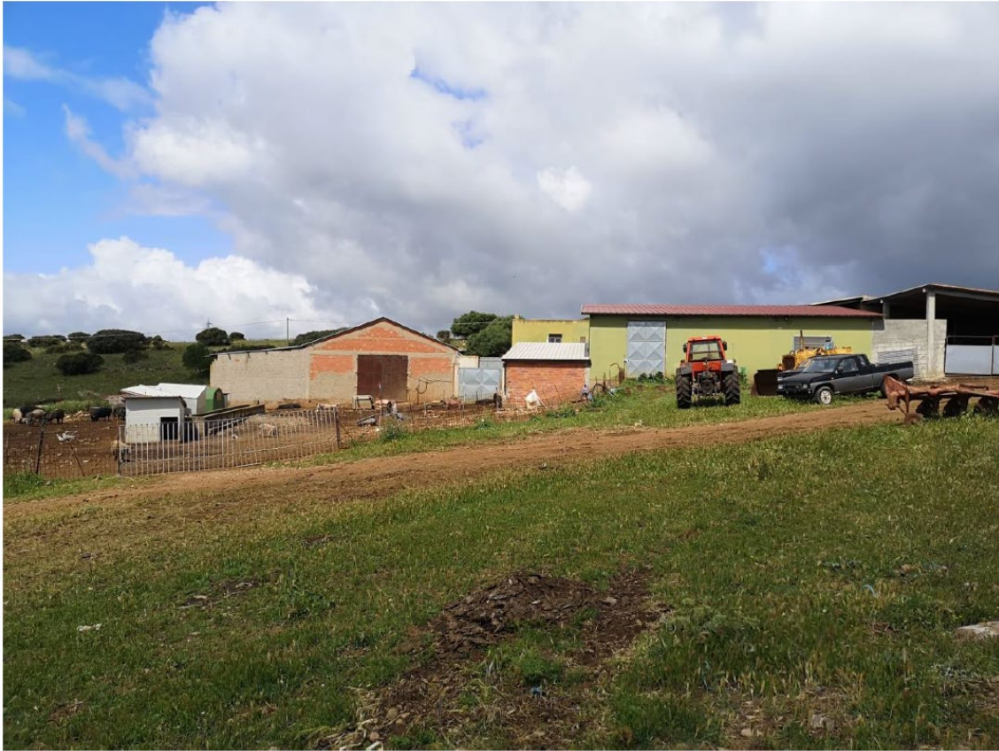
Figura 5 - Facciata del fabbricato esposto all'effetto di Shadow Flickering
