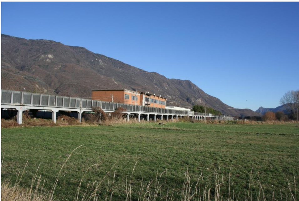
Figura 18 - Tratto di canale NIE sopraelevato in comune di Bruzolo
