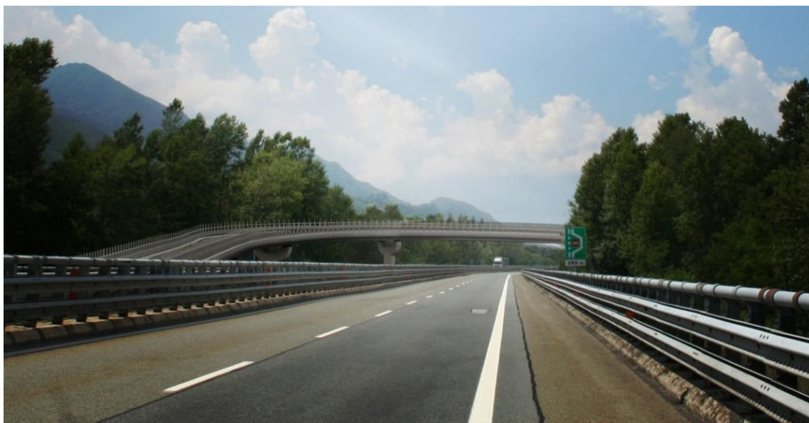
Figura 28 - Vista verso monte (ambito svincolo ovest) successivamente alla nuova rampa 1 di uscita in direzione Bardonecchia
