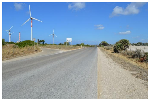
Figura 3.63 - Strada Provinciale 57 sede di posa del cavidotto MT
