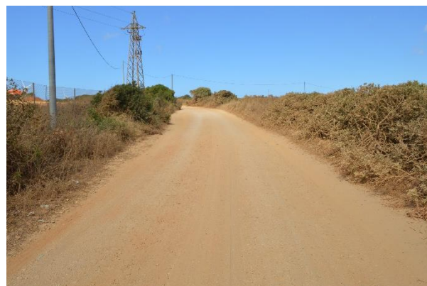
Figura 3.61 - Sterrato sede di posa del cavidotto MT, costeggiato da vegetazione arbustiva a scarso grado di conservazione
