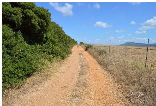
Figura 3.88 - Sterrato da adeguare per l'accesso all'ingresso 4 e 5. Tratto intermedio. A destra: lotto maggiore
