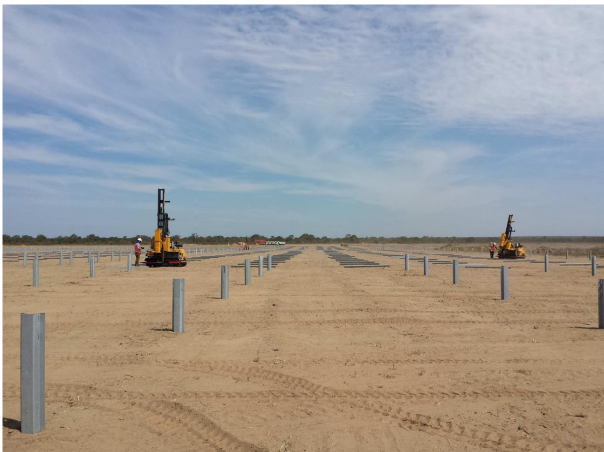
Figura 2.7 – Fase di infissione dei pali con profilo omega (fonte Convert)
