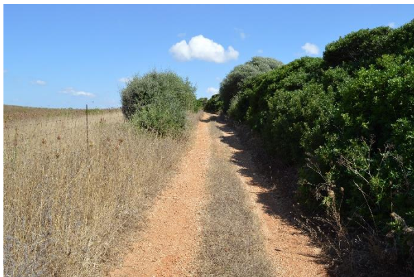
Figura 3.89 - Sterrato da adeguare per l'accesso all'ingresso 4 e 5. Tratto intermedio
