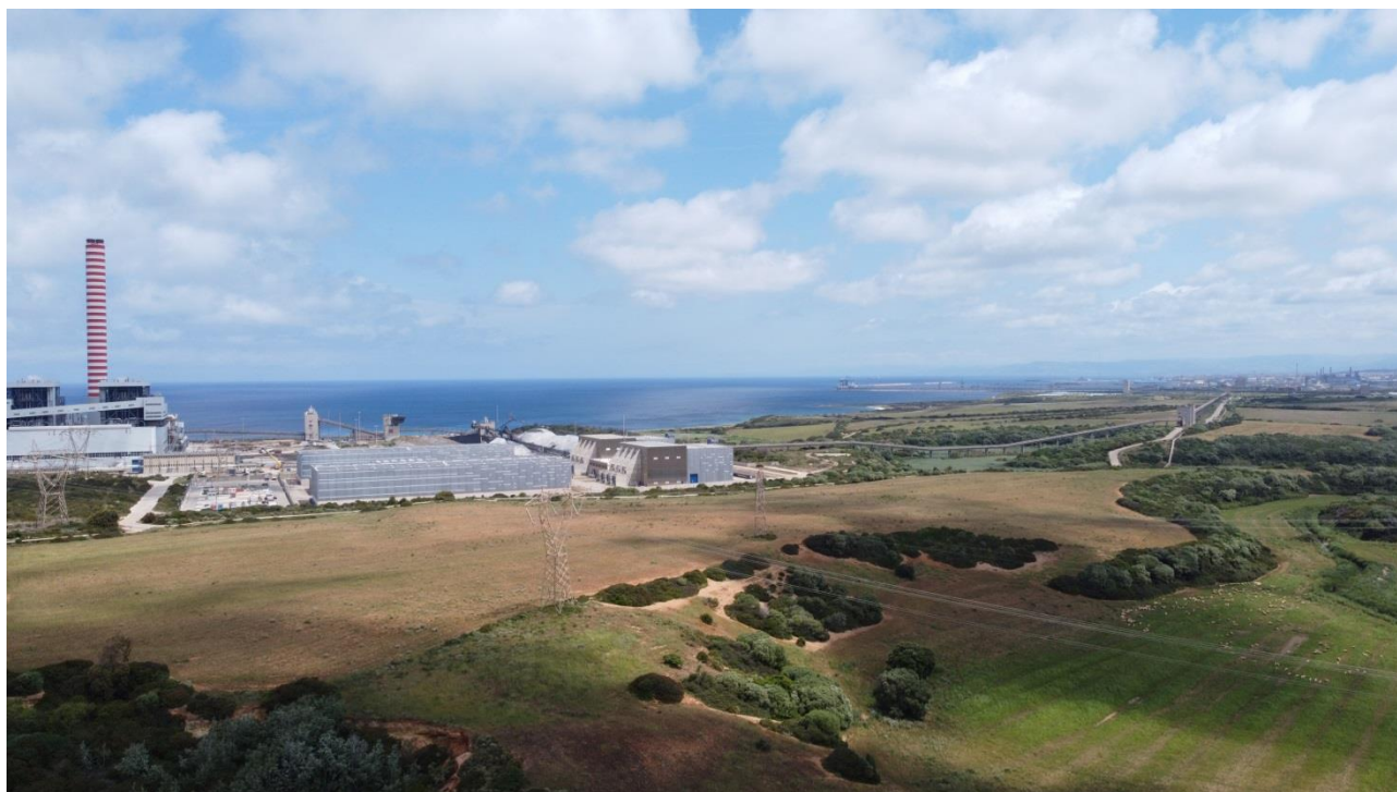
Figura 7.6 – Sito di ubicazione della sottostazione elettrica, centrale termoelettrica di Fiume Santo e, sullo sfondo a destra, veduta del polo industriale di Porto Torres
