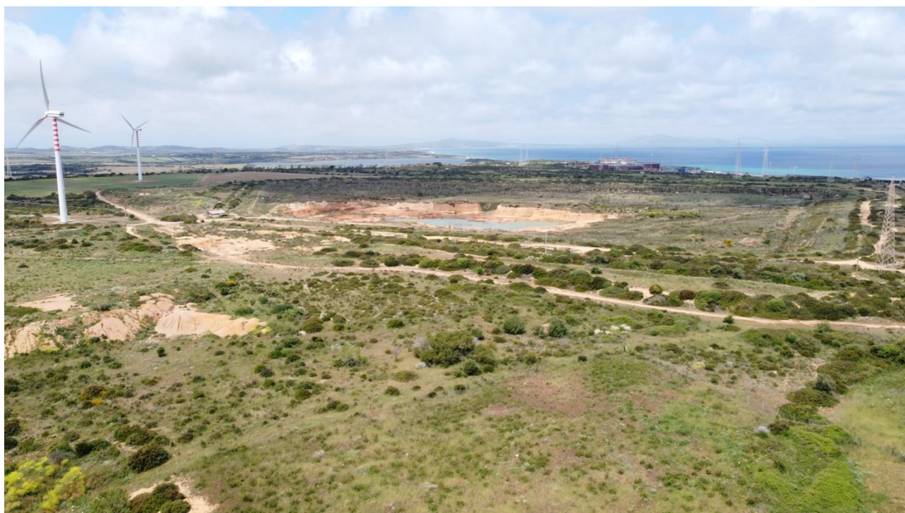
Figura 7.7 – Veduta del vecchio bacino Enichem e degli aerogeneratori del parco eolico di Enel Green Power, immediatamente a Ovest della centrale termoelettrica di Fiume Santo
