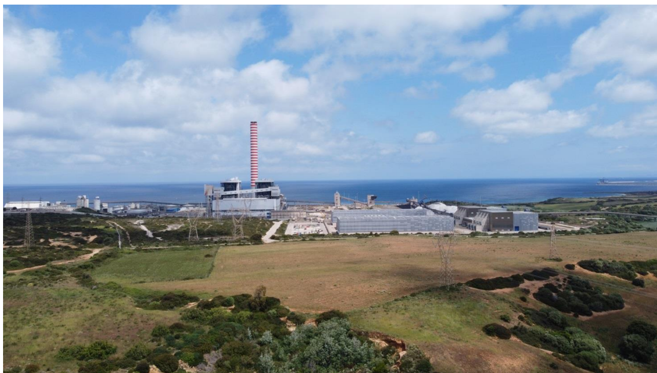
Figura 7.5 – Sito di ubicazione della sottostazione elettrica, immediatamente prospiciente la centrale termoelettrica di Fiume Santo
