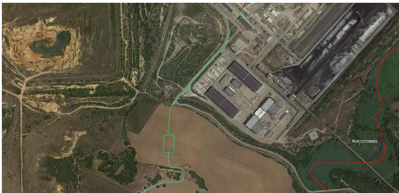
Figura 1.6 – Particolare area cabina utente e stazione.
