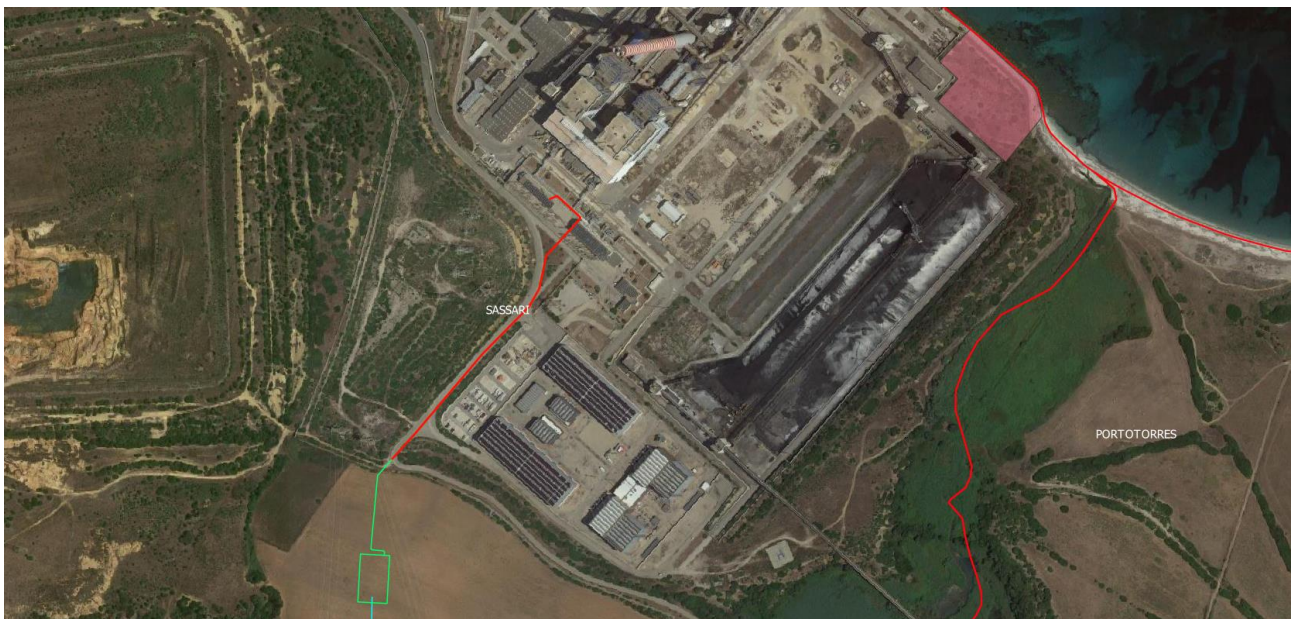
Figura 5.11 – Cavidotto I tratto.
