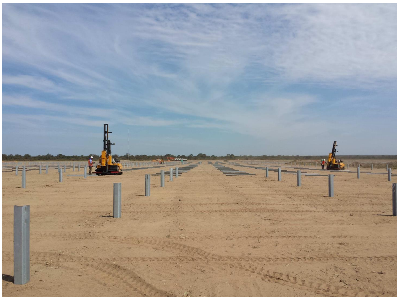
Figura 2.2 – Fase di infissione dei pali con profilo omega (fonte Convert)
