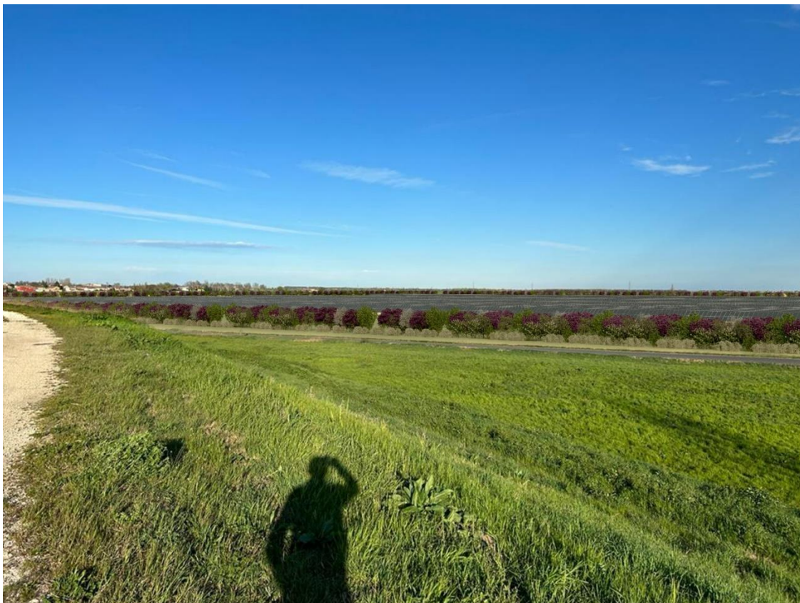
Figura 42 - Ipotesi visiva dall'argine Panaro durante la fase di esercizio di "Bondeno Nord" con opere di mitigazione
