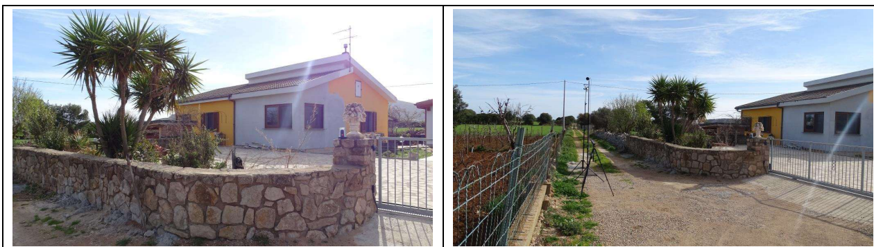
Figura 3.7-3 - Documentazione fotografica postazione di monitoraggio
