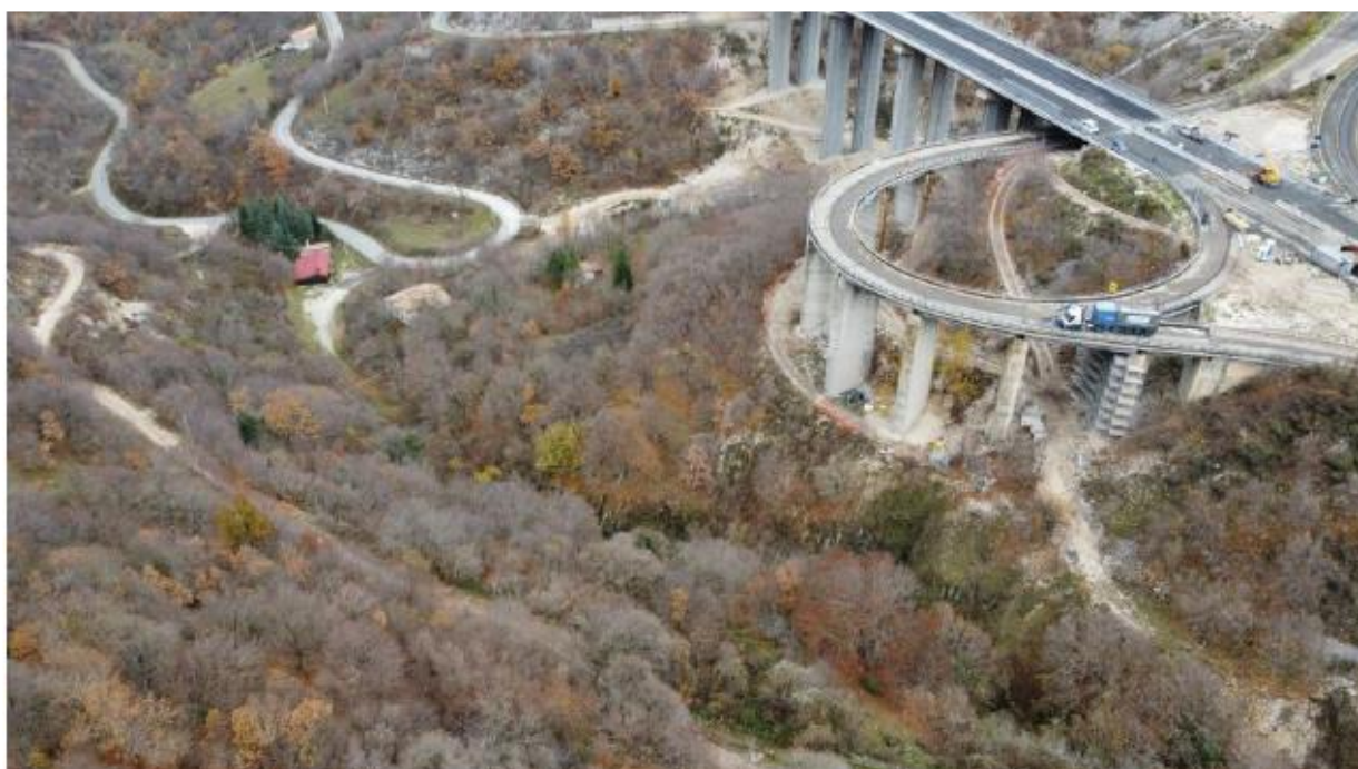
Figura 14 – Stato attuale area sottostante il viadotto
