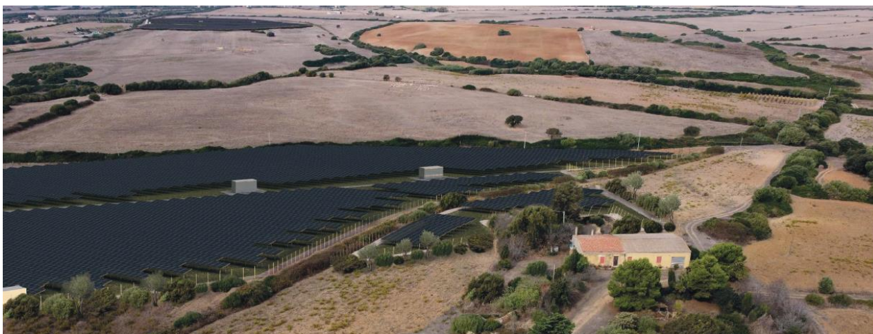
FIGURA 29 – INSERIMENTO DEL PROGETTO ALL'INTERNO DEL CONTESTO TERRITORIALE CON RELATIVE MISURE DI COMPENSAZIONE E MITIGAZIONE – VISTA A VERSO N-O IN CUI È POSSIBILE APPREZZARE ENTRAMBE LE PORZIONI DELL'IMPIANTO – ESTRATTO DALL'ELABORATO GRAFICO STINTINO-IAT17
