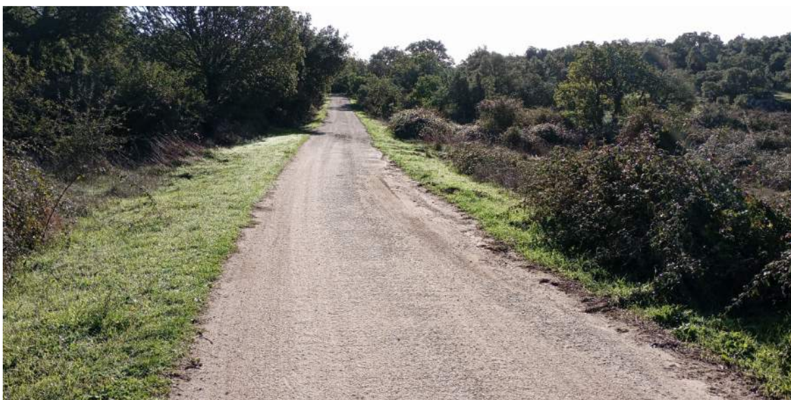
Figura 4.9 – Esistente viabilità in adeguamento lungo l'accesso alle postazioni WTG002, WTG003, WTG004 E WTG006 facente parte della viabilità di progetto
