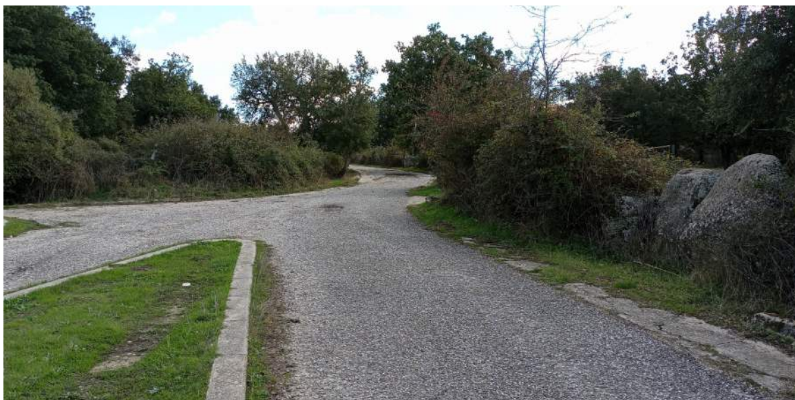
Figura 4.1 – Inizio dell’esistente viabilità da adeguare lungo la SP41 facente parte della viabilità di progetto.
