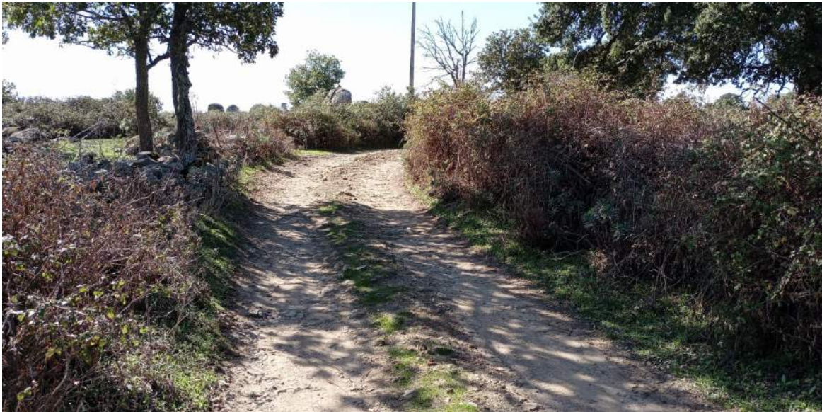
Figura 4.7 –Strada locale da adeguare lungo la viabilità di accesso alla postazione WTG001
