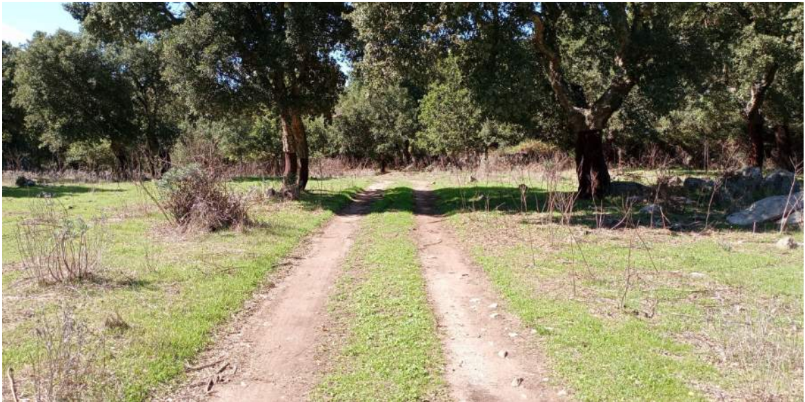
Figura 4.17 – Viabilità in adeguamento di accesso alle postazioni WTG008
