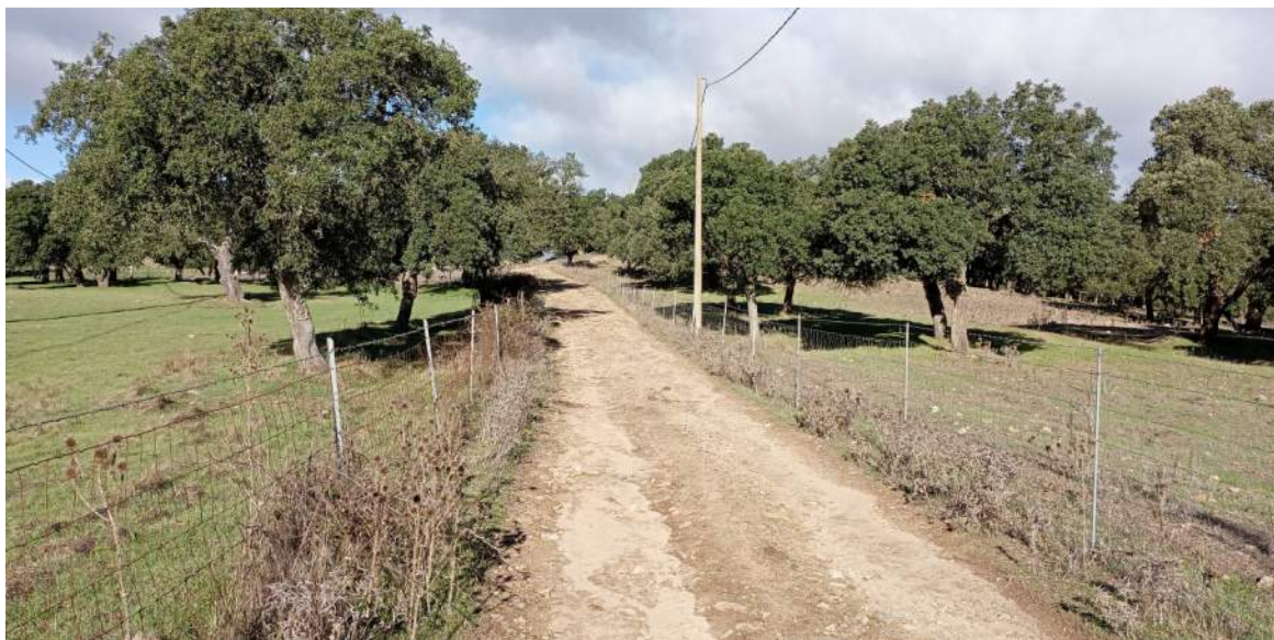
Figura 4.23 – Viabilità in adeguamento di accesso alla postazione WTG014
