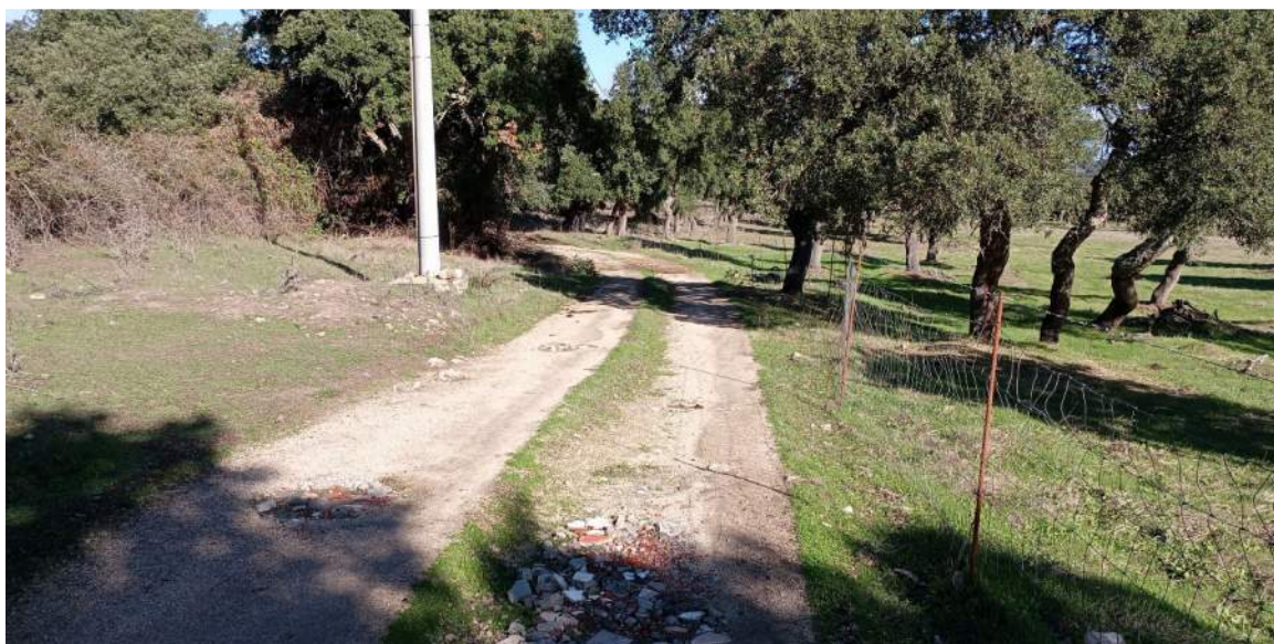
Figura 4.25 – Viabilità in adeguamento di accesso alla postazione WTG015
