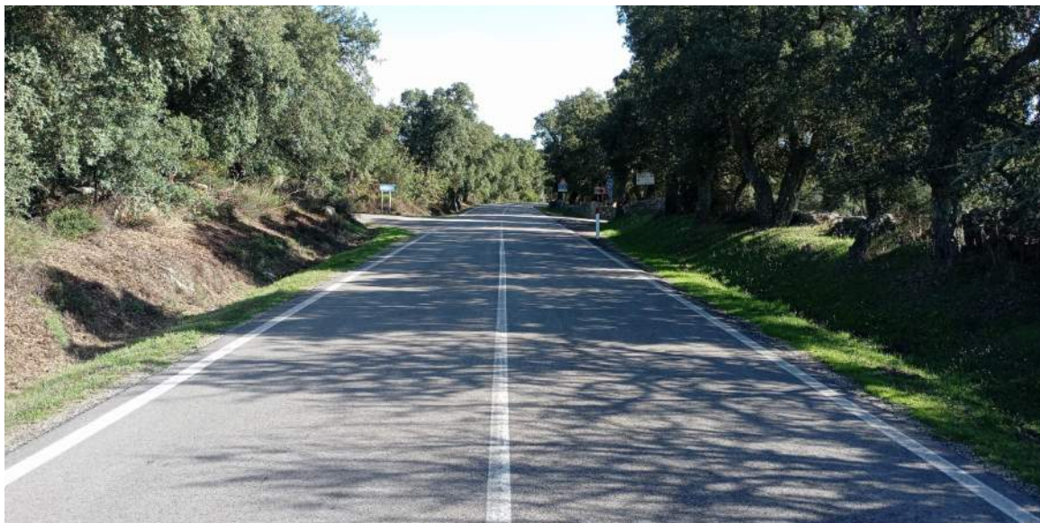
Figura 4.3 – Raccordo tra la Sp41 e l’area di manovra per accesso alle WTG013, WTG014 e WTG015. Direzione di scatto NE
