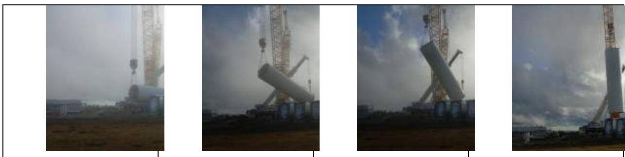
Figura 4.42 – Schema delle fasi di sollevamento dei componenti dell’aerogeneratore (Fonte sito web
