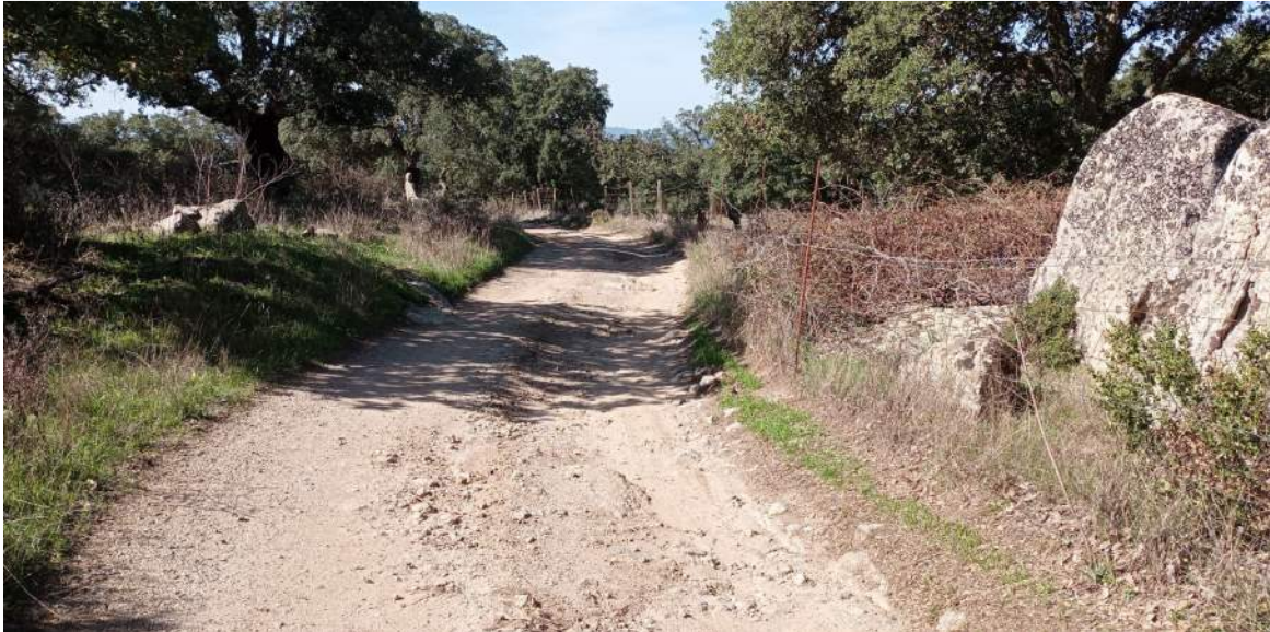
Figura 4.5 –Strada locale da adeguare lungo la viabilità di accesso alla postazione WTG005
