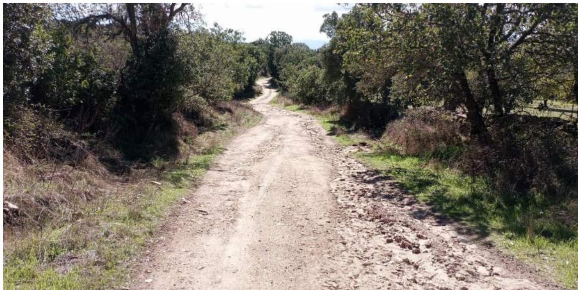
Figura 4.14 – Viabilità in adeguamento di accesso alle postazioni WTG007, WTG008, WTG009 e WTG010
