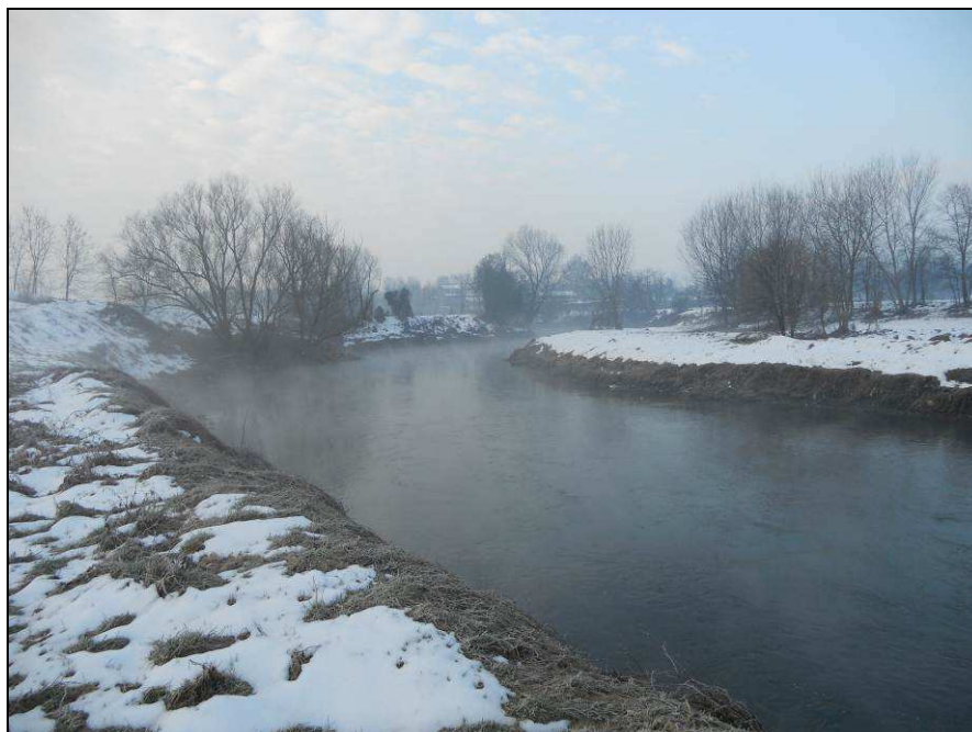
Foto 2 - Tratti spondali del fiume Lambro nel tratto in cui è previsto l'attraversamento in Microtunnel della nuova condotta. Si può notare lo sviluppo limitato e discontinuo della vegetazione di ripa (prog. Km 9+100)
