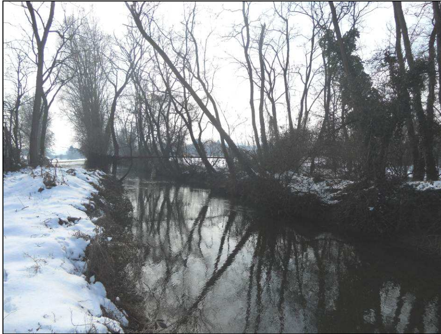
Foto 1 - Cavo Tris in comune di Mulazzano, in connessione con il sistema ambientale della Muzza (attraversamento Opere in progetto con Trivellazione Orizzontale Controllata); si tratta di uno dei tratti di livello 3 nell'ambito di uno dei nodi a maggior sensibilità ambientale (prog. Km 2+050)
