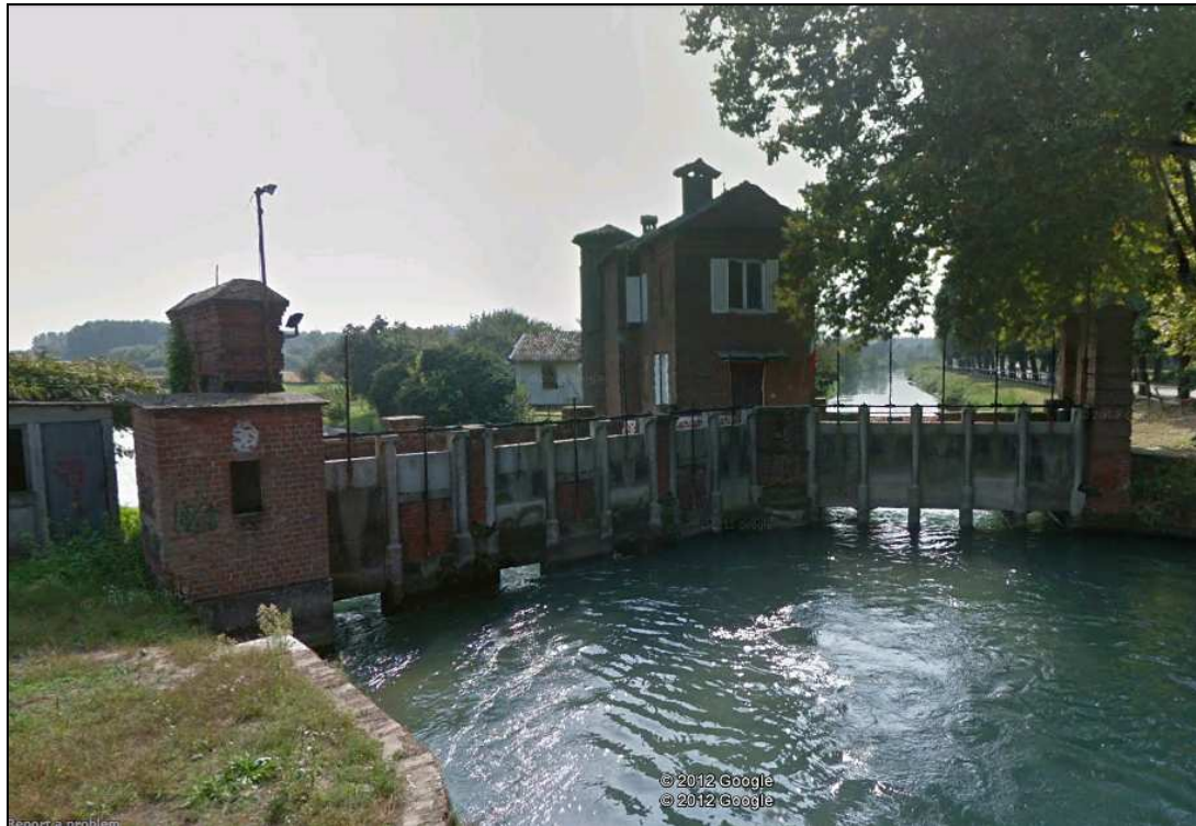
Figura 1: Sezione terminale del Canale Quintino Sella con inizio dei due canali Sub. Pavia e Sub. Mortara
