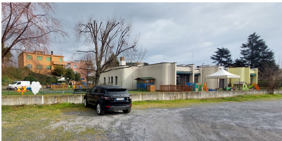
Figura 5. Scuola Materna confinante al lotto d'intervento
