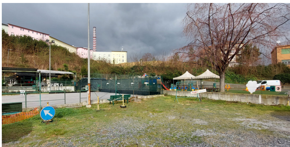
Figura 4. Bocciofila oggetto di demolizione – via Sabauzia
