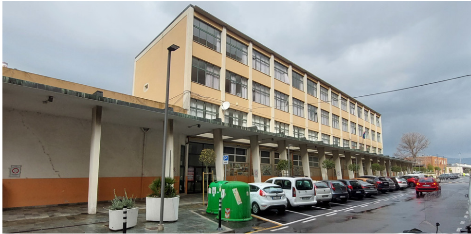
Figura 6. Scuola oggetto di demolizione – via XXV Aprile
