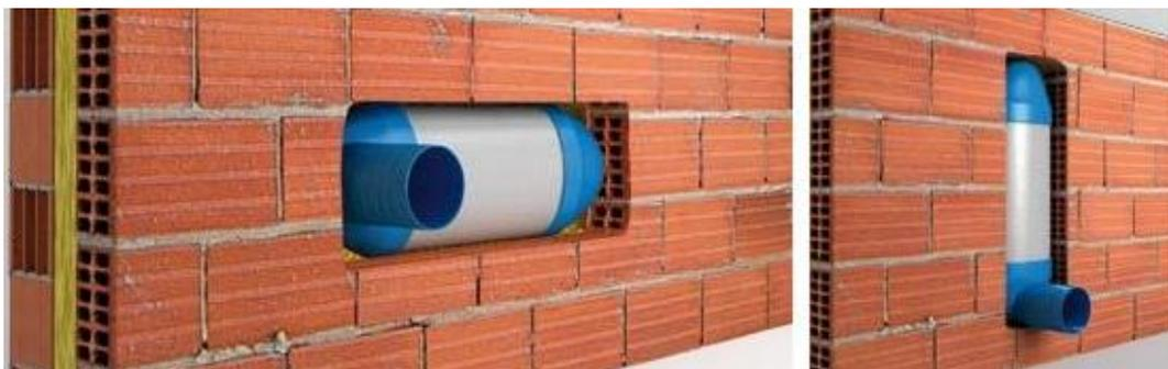
Fase 3: una volta posizionato il silenziatore, chiudere la traccia con mattoni e/o malta cementizia, lasciando fuoriuscire la parte curva del sistema di ventilazione sia all'interno che all'esterno della parete.
