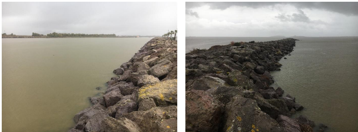
Figura 22: Opere di protezione che delimitano l'area portuale costituite da massi privi di vegetazione.
