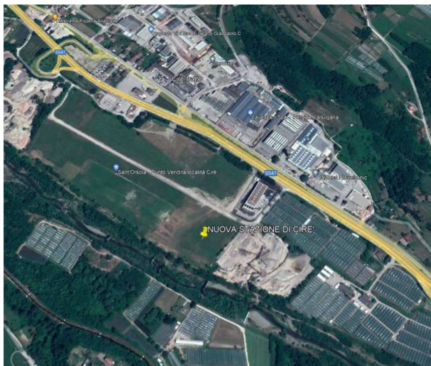
FIGURA 10: UBICAZIONE DEL SONDAGGIO (SOND_01)
