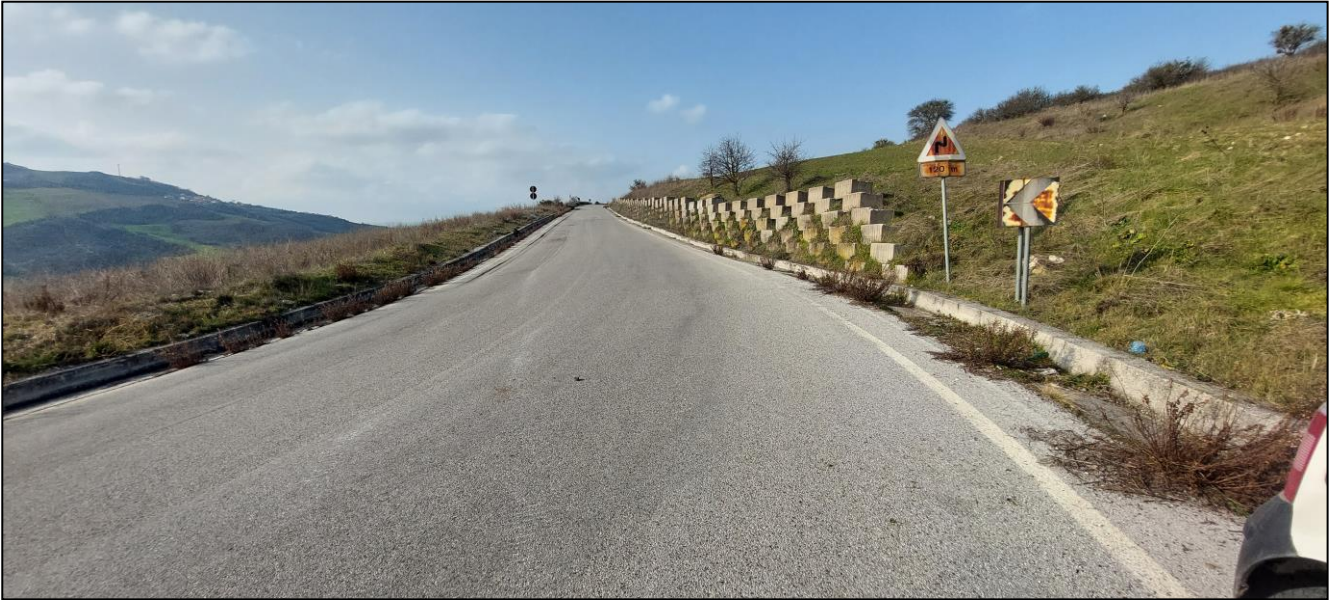
VISTA DELLA STRADA PROVINCIALE ADIACENTE AL SOTTOCAMPO 2 PRIVA DI DANNI
