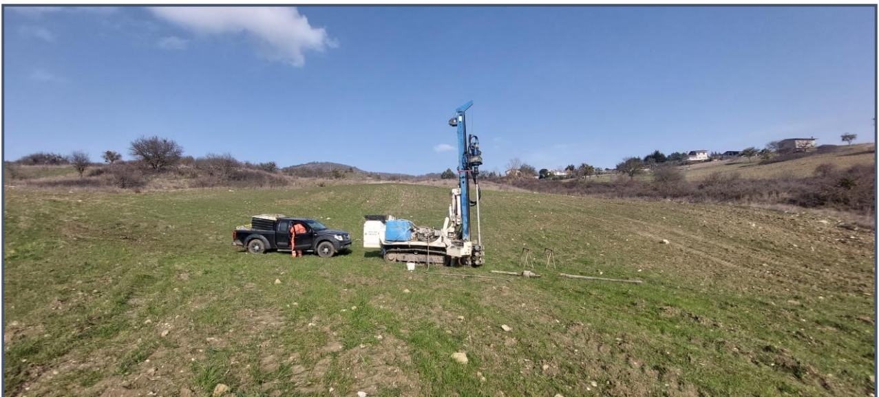
POSTAZIONE SONDAGGIO S2
