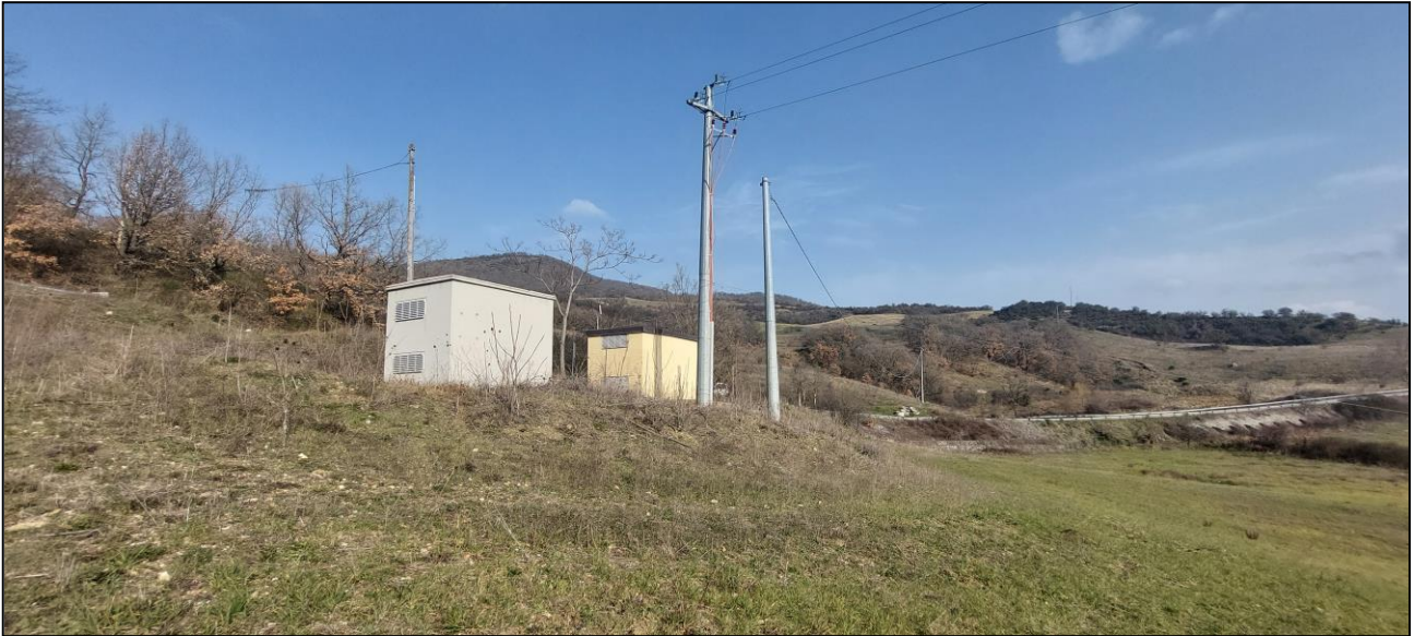
VISTA DELLE OPERE INTEGRATE NELLA PARTE DI MONTE DEL VERSANTE D'INTERESSE CLASSIFICATO COME ASV NEL SOTTOCAMPO 1
