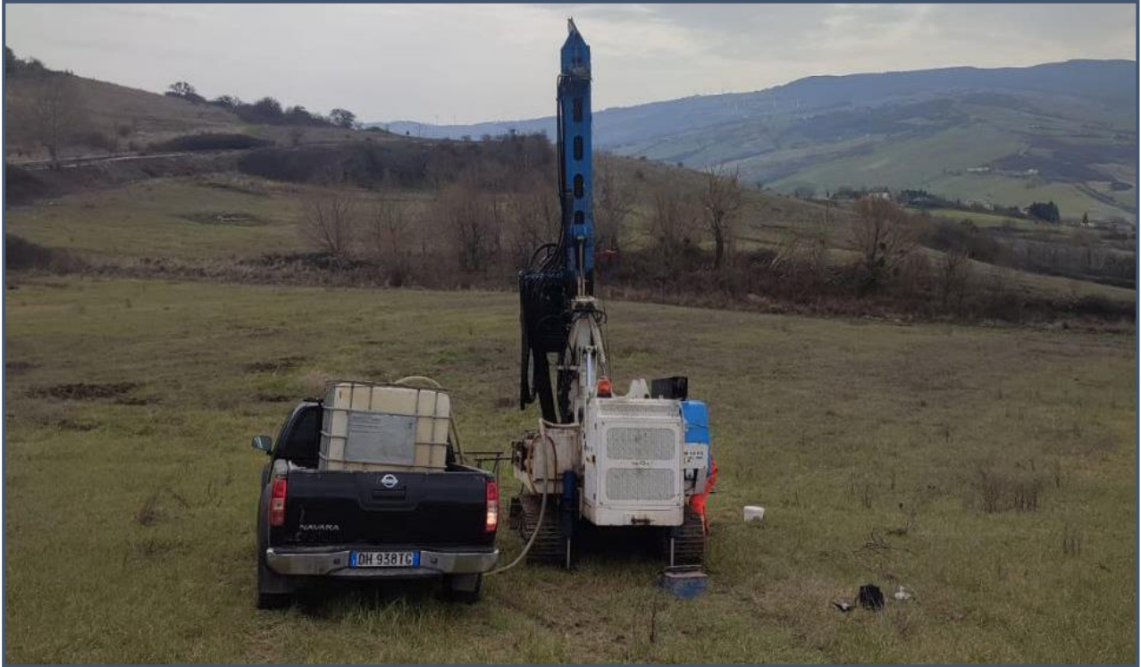
POSTAZIONE SONDAGGIO S1
