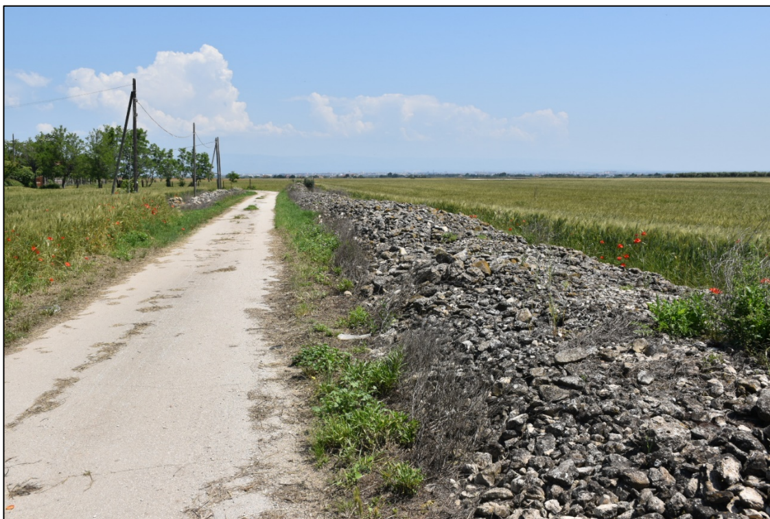
Figura 18 Muretto a secco "Il Posticchio" - 1
