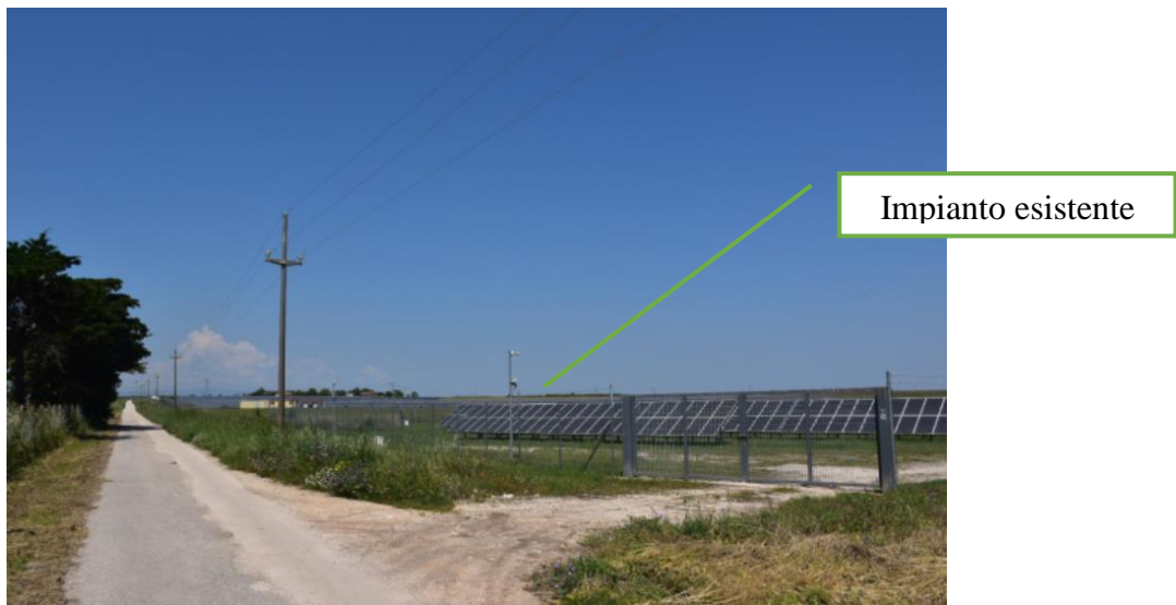
Figura 11 – Impianto fotovoltaico esistente
