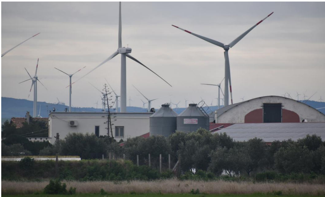
Figura 16 - Veduta (teleobiettivo) di eolico dietro uno stabilimento (punto 2)
