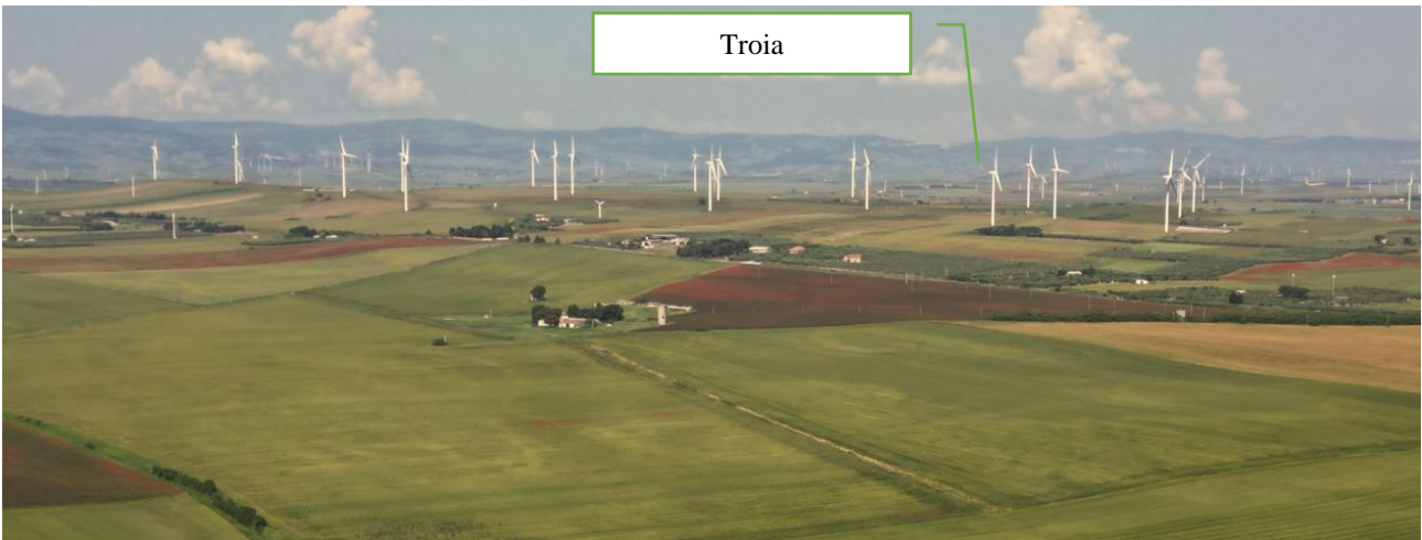
Figura 15 – Veduta eolico verso Troia
