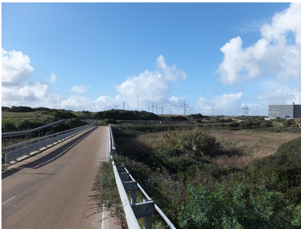
Foto 5 – Nuova stazione elettrica Terna e parco eolico
