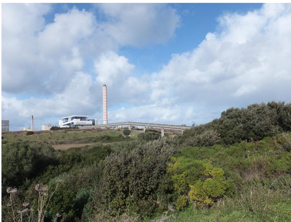
Foto 6 – Vista della centrale e del carbondotto da Sud-Est
