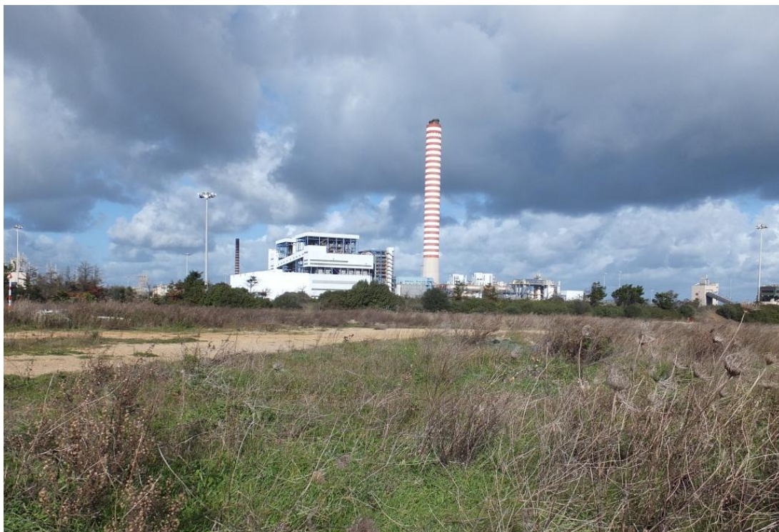
Foto 1 – Vista di insieme della centrale esistente
