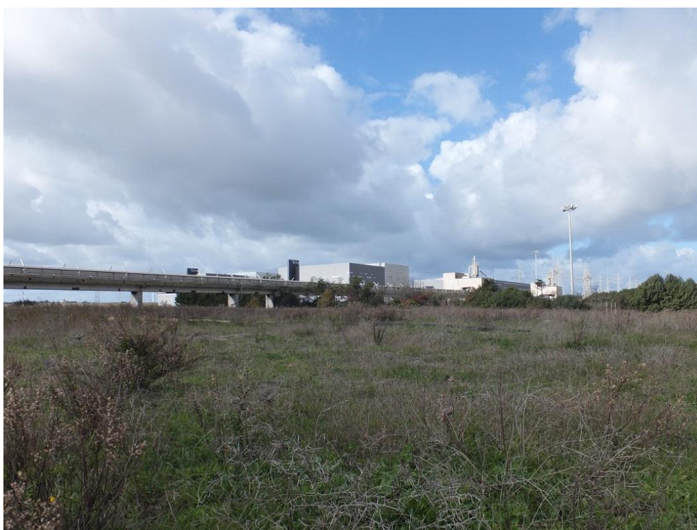
Foto 4 – Nuova stazione elettrica Terna e carbondotto
