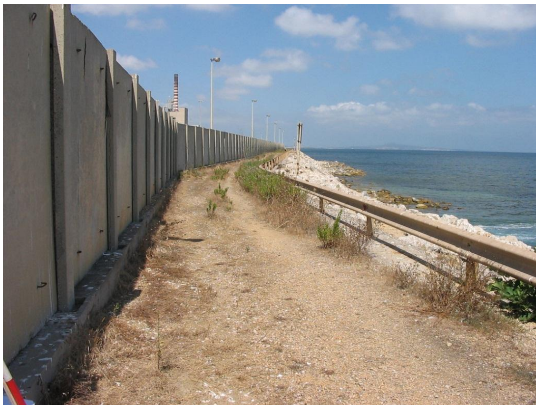
Foto 2 – Muro perimetrale all'area di centrale, a ridosso del mare
