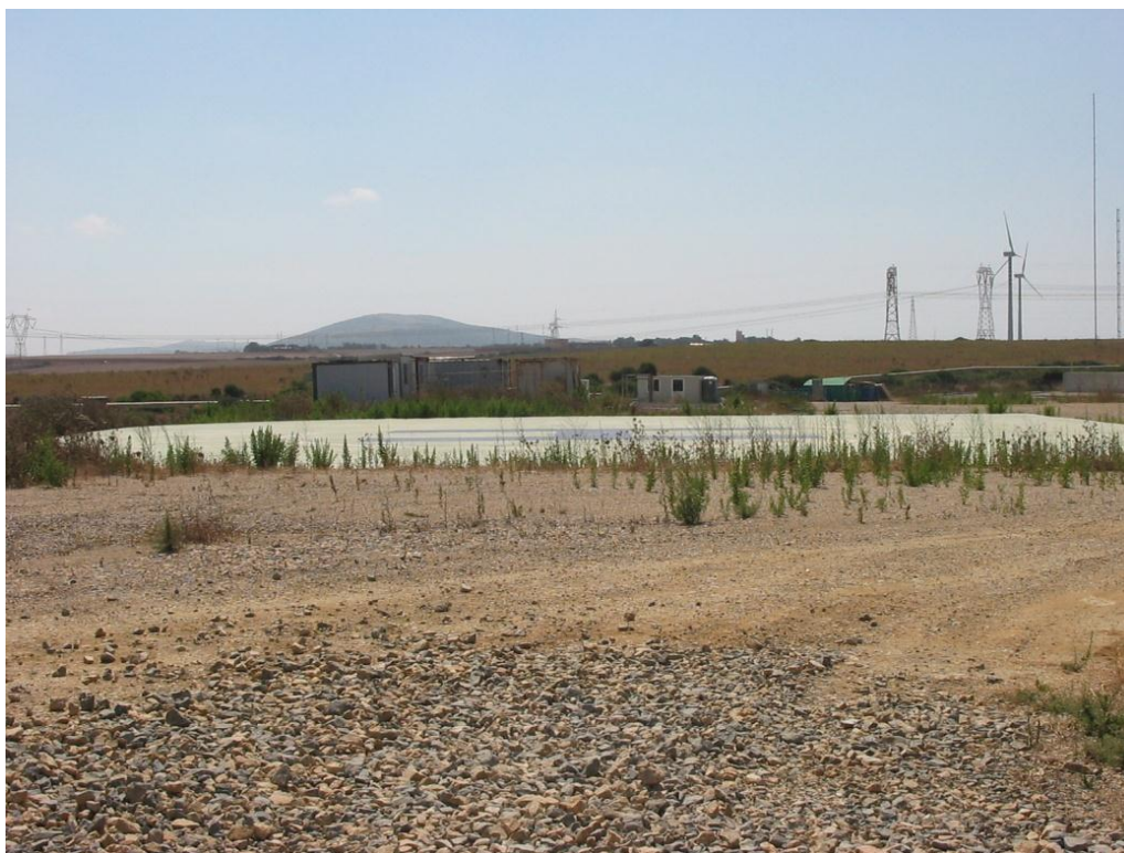
Foto 10 – Pista di atterraggio degli elicotteri in prossimità dell'ingresso della stazione SAPEI
