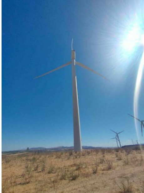
Figura 8 - Panoramica: attuale aerogeneratore MAZ-23 da sostituire con aerogeneratore n. 2 repowering
