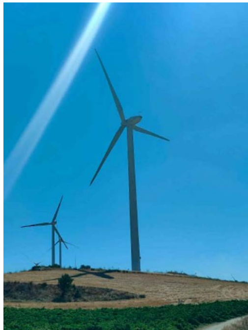
Figura 12 - Panoramica: attuale aerogeneratore MAZ-31 da sostituire con aerogeneratore n. 6 repowering
