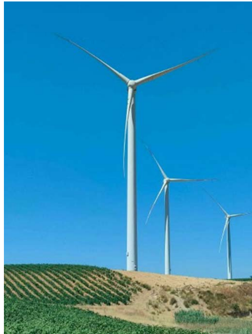
Figura 18 - Panoramica: attuale aerogeneratore MAZ-55 da sostituire con aerogeneratore n. 12 repowering
