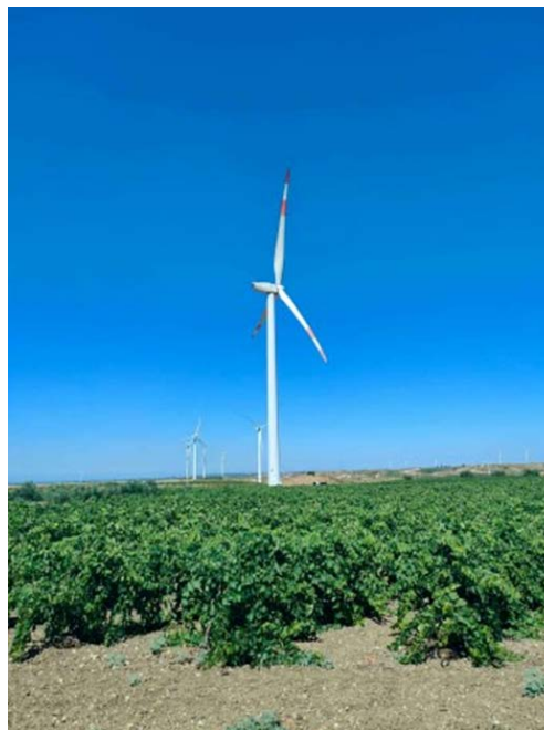
Figura 17 - Panoramica: attuale aerogeneratore MAZ-56 da sostituire con aerogeneratore n. 11 repowering
