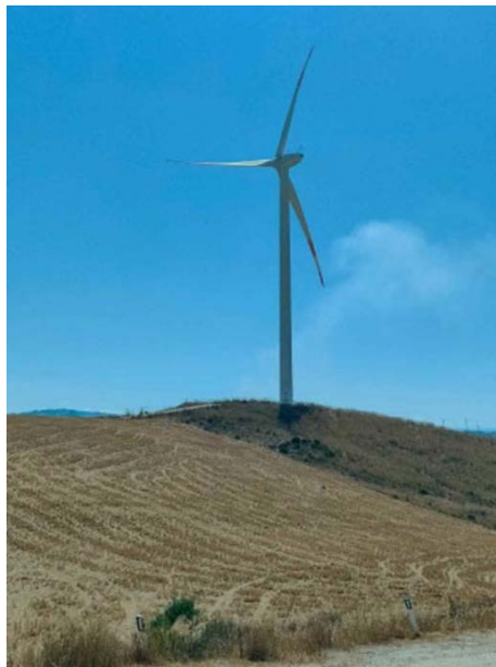
Figura 14 - Panoramica: attuale aerogeneratore MAZ-35 da sostituire con aerogeneratore n. 8 repowering
