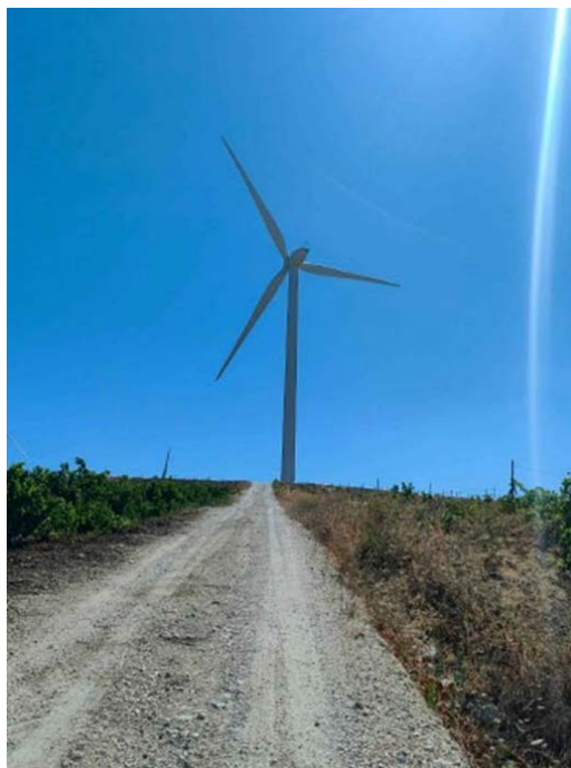
Figura 10 - Panoramica: attuale aerogeneratore MAZ-28 da sostituire con aerogeneratore n. 4 repowering
