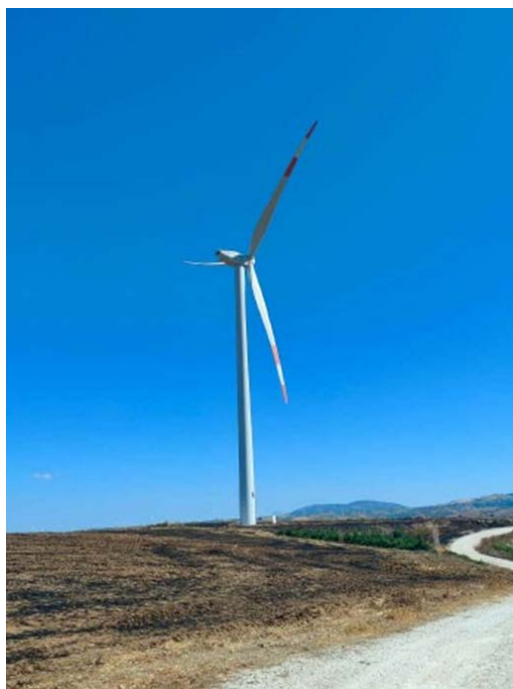
Figura 11 - Panoramica: attuale aerogeneratore MAZ-29 da sostituire con aerogeneratore n. 5 repowering
