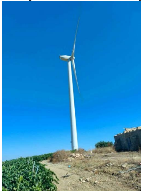
Figura 9 - Panoramica: attuale aerogeneratore MAZ-25 da sostituire con aerogeneratore n. 3 repowering
