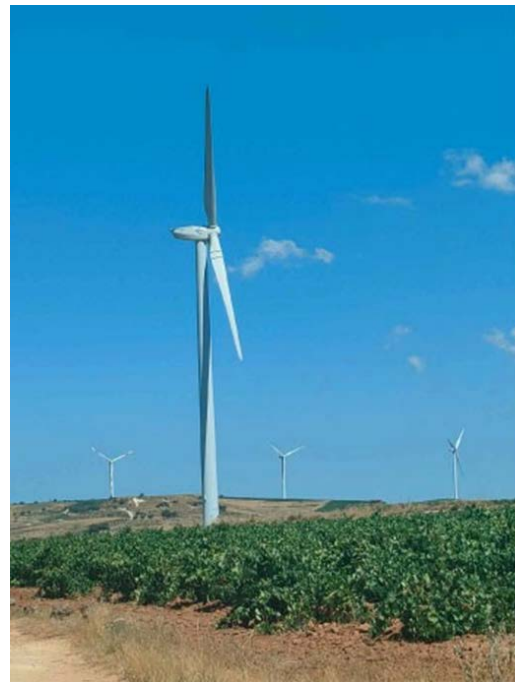
Figura 19 - Panoramica: attuale aerogeneratore MAZ-52 da sostituire con aerogeneratore n. 13 repowering
