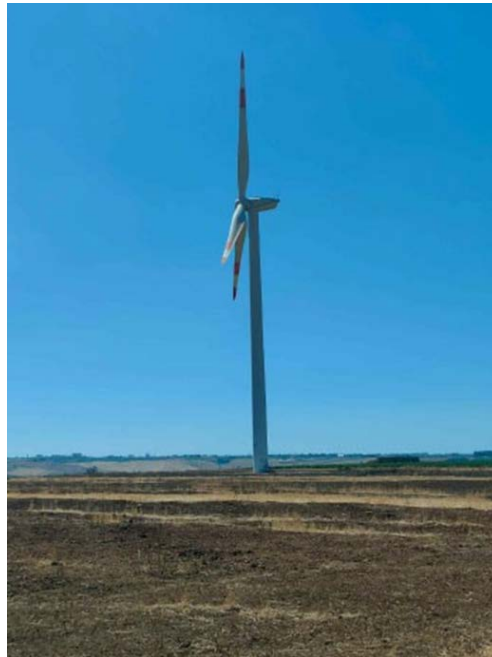
Figura 16 - Panoramica: attuale aerogeneratore MAZ-57 da sostituire con aerogeneratore n. 10 repowering
