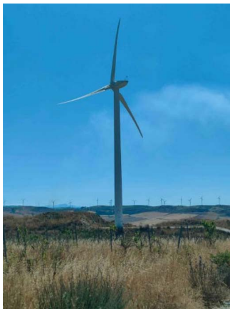
Figura 15 - Panoramica: attuale aerogeneratore MAZ-38 da sostituire con aerogeneratore n. 9 repowering
