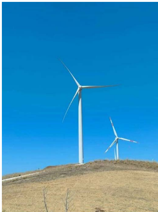
Figura 13 - Panoramica: attuale aerogeneratore MAZ-33 da sostituire con aerogeneratore n. 7 repowering
