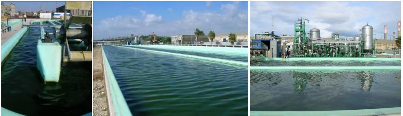
**Figura 5. Impianto pilota di Gela: unità di coltivazione microalghe e sezione di recupero bio-olio.**
