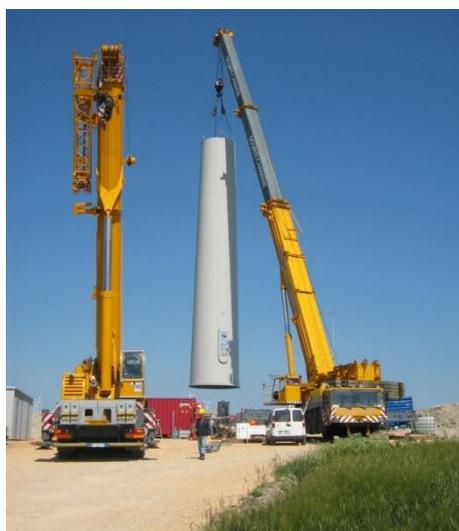
**Figura 5:** elemento torre smontata da trasportare
