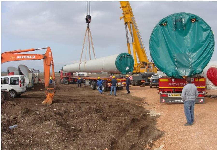
**Figura 6:** elementi torre smontata da trasportare
