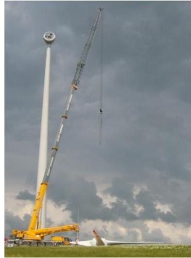
**Figura 2:** rimozione eliche e mozzo
