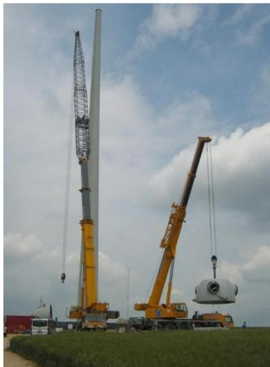
**Figura 3:** smontaggio navicella
