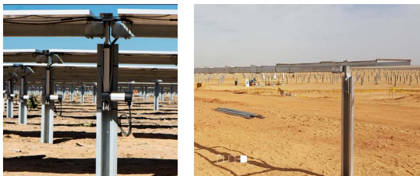
Figura 6 - Particolare strutture ad inseguimento ed attuatore
