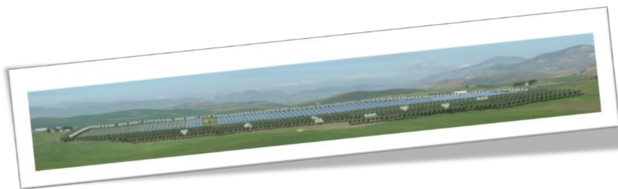
Figura 39 - Impianto fotovoltaico da 5 MW, "Heliospower", Monreale /(PA) 2010
