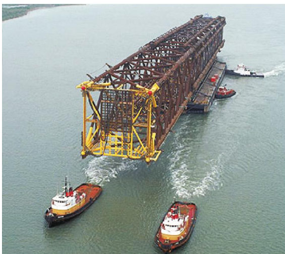
Figura 3.47 – Pilone di sostegno in navigazione per una Compilant tower (a sinistra) e piattaforma operativa (a destra) (fonte: www.off-shore-technology.com )
