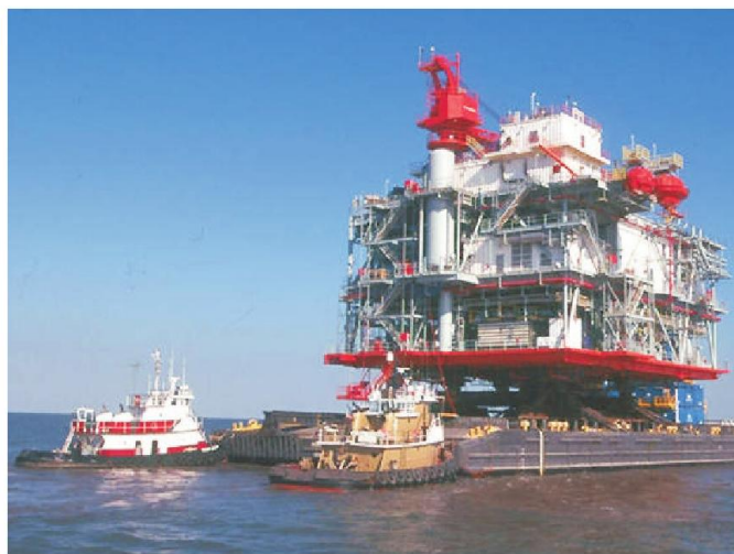
Figura 3.47 – Pilone di sostegno in navigazione per una Compilant tower (a sinistra) e piattaforma operativa (a destra) (fonte: www.off-shore-technology.com )
