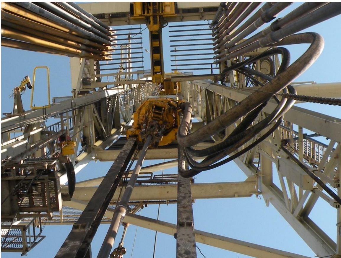
Figura 3.51 – Torre di perforazione dove il moto rotazionale è affidato al top drive
