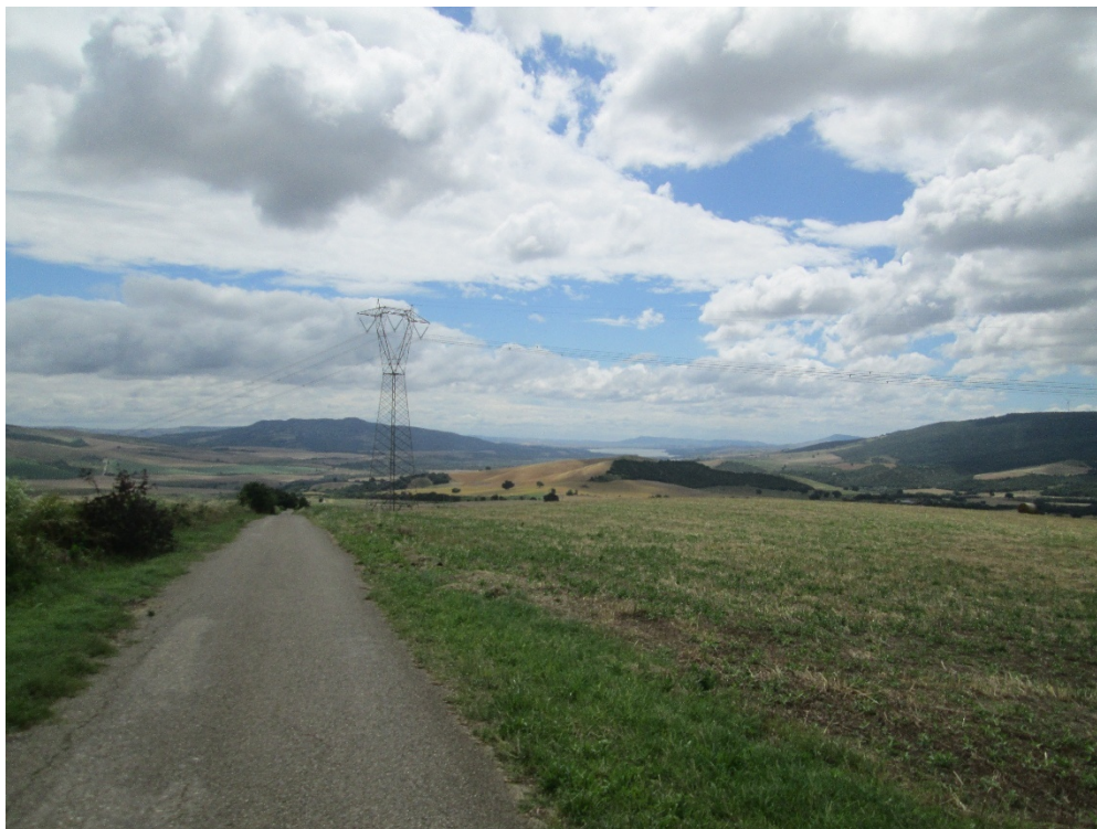
Ripresa fotografica in direzione del cavidotto, traguardando verso Est lungo le p.lle 82 e 84
