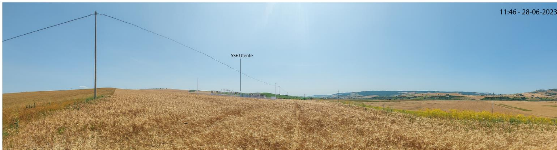
Figura 40 Punto di scatto 5: la sottostazione utente risulta appena visibile
