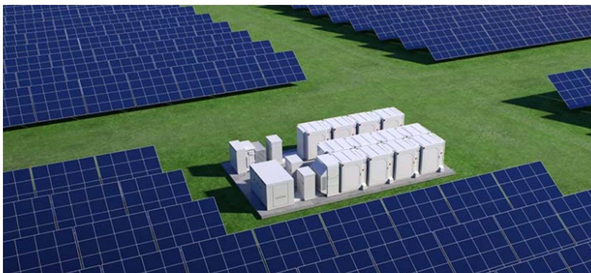
Figura 34: esempio di sistema di stoccaggio per impianto fotovoltaico - Sunstack
