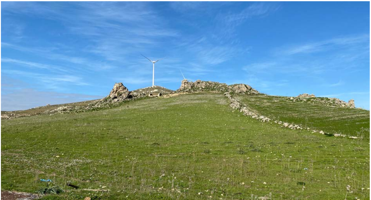
Figura 134: area settentrionale dell'impianto
