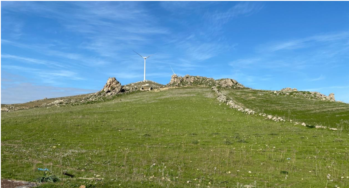
Figura 46: la porzione settentrionale dell'impianto occupa un' ampia area in forte pendenza verso il promontorio di Pietra Pizzuta, che la delimita a nord. L'areale si presenta piuttosto accidentato per la presenza di numerosi affioramenti di nuclei rocciosi, intervallati da ampi spazi ricoperti da copertura vegetale spontanea.
