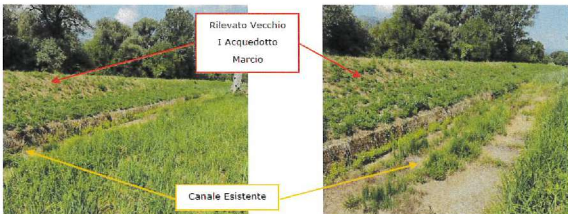
Fig.16 rilevato del vecchio primo acquedotto Marcio in affincamento al fosso il fumetto
