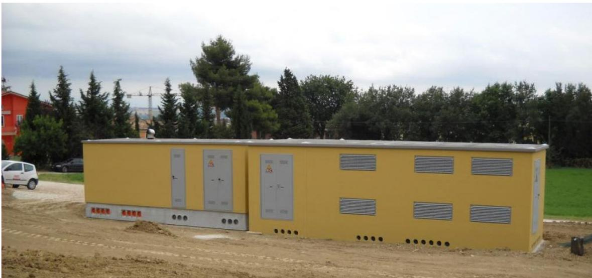
La cabina di campo **tipo b** sarà costituita da 1 vano utente BT e 1 vano per TRAFI MT/BT 20/0,4 kV 1,00 MVA, con dimensioni pari a 6,70 m x 2,50 m ed altezza fuori terra pari a 2,60 m, realizzate in c.a.v. prefabbricato, componendosi di 2 elementi monolitici ovvero la vasca, che svolge la doppia funzione di
