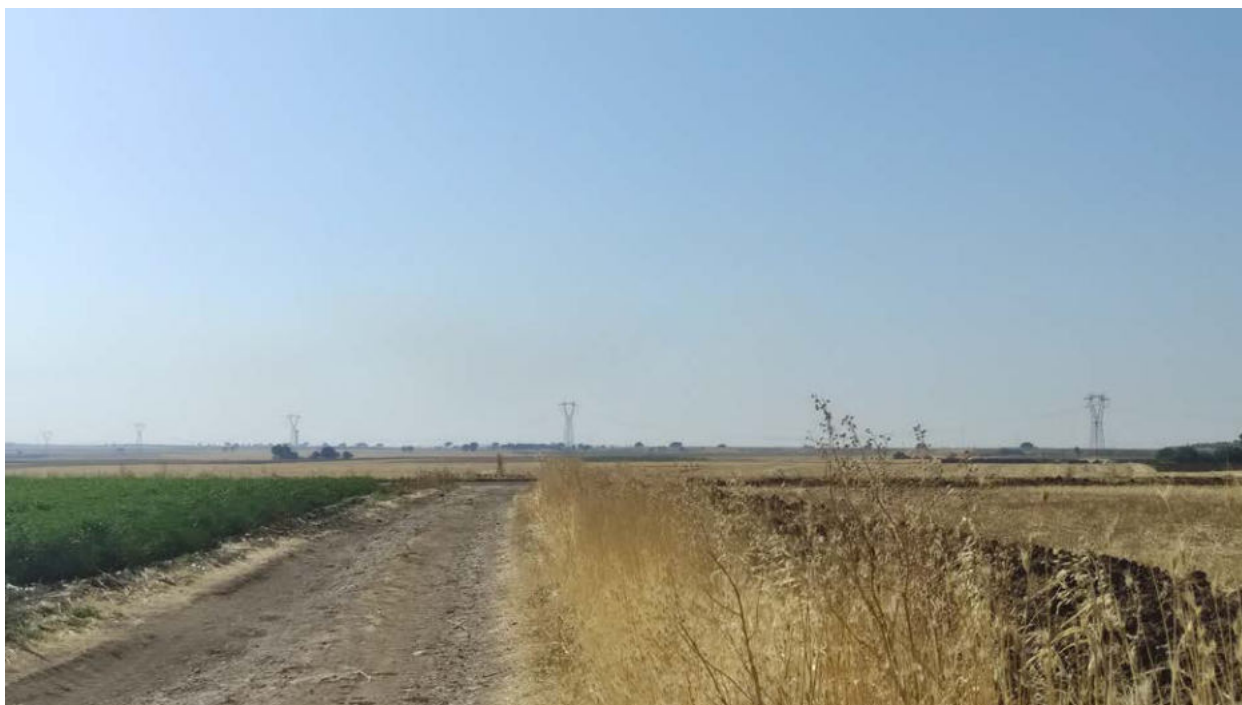
Vista della strada rurale interessata dalla realizzazione del cavidotto MT di collegamento dell'impianto alla sottostazione di trasformazione e consegna 30/36 kV, sullo sfondo l'elettrodotto 380 kV "Melfi 380 – Genzano 380".
