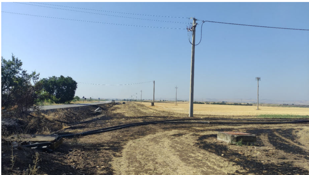
Vista dal punto di accesso ai terreni interessati dal progetto dell'impianto agrovoltaiico (confine Est).
