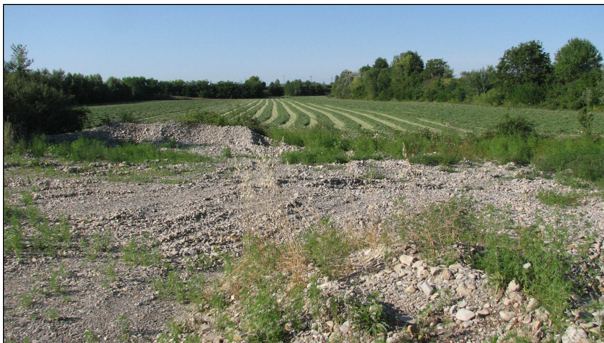
In primo piano: riempimento parziale del fondo di cava senza recupero del suolo.
