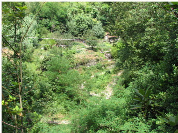
Versante terrazzato esposto a sud est con evidenti segni di degrado superficiale
