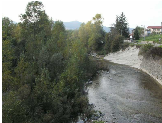
Fig. 4.9/F- stazione monitoraggio I.F.F. VEG-GA-010, tratto a valle (22 ottobre 2012)
