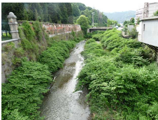
Fig. 4.3/B- Torrente Buria all'esterno del cimitero nella stazione FAU-GE-060 (20 giugno 2012)
