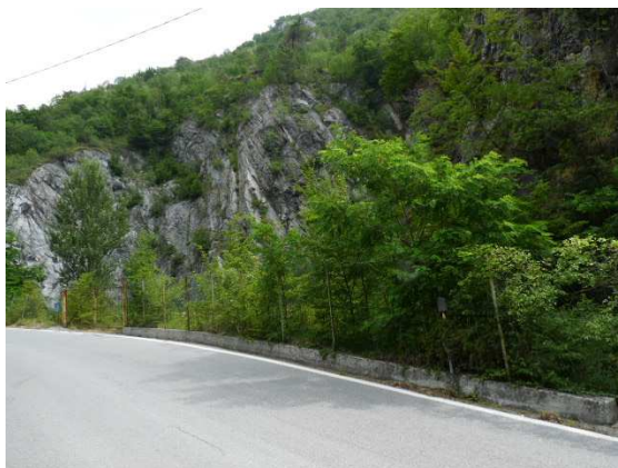
Fig. 4.10/A- area di cava dismessa presso la stazione FAU-CM-040 (25 giugno 2012)
