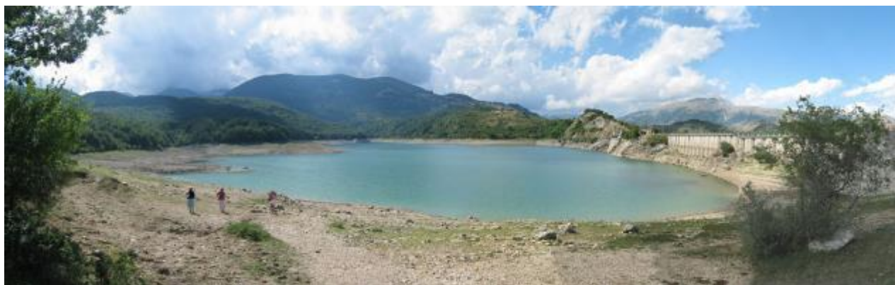
Figura 2-1: Serbatoio di Montagna Spaccata
