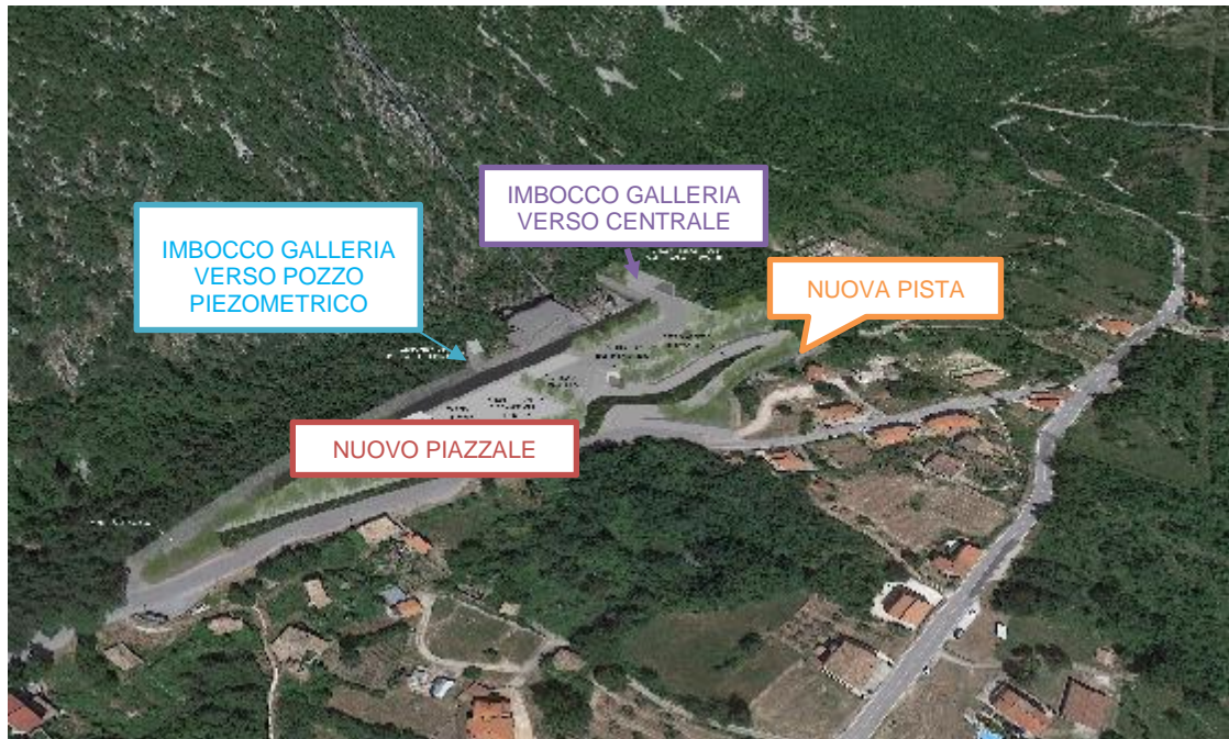
Figura 8-8. Pista di accesso al nuovo piazzale alla centrale esistente del Pizzone e imbocco delle due nuove gallerie dal piazzale della centrale esistente.
