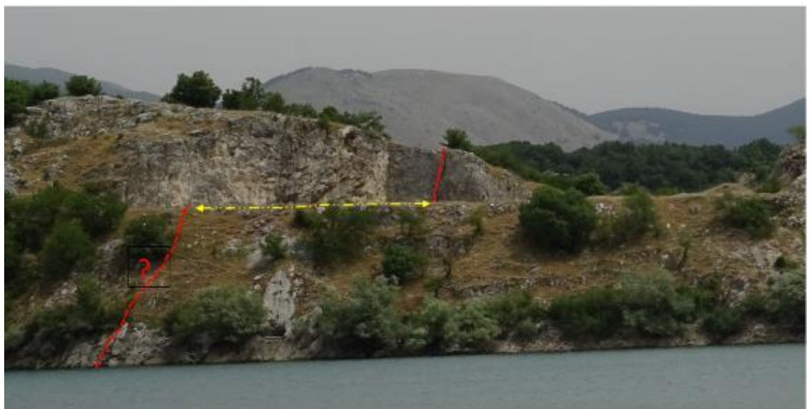
Figura 4-10 - Invaso di Montagna Spaccata. Vista di dettaglio della precedente foto della spalla sinistra della diga principale. Dalla finestra generata da una cava di prestito dismessa, si nota che il calcare è interessato superficialmente dalla presenza di molte famiglie di giunti. Una frattura molto aperta potrebbe estendersi anche sotto al piano della cava.
