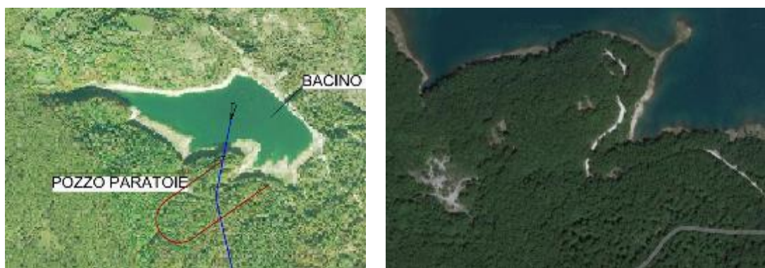
Figura 8-6. Galleria di accesso al pozzo paratoie. A sinistra la strada esistente da cui si diparte la galleria.
