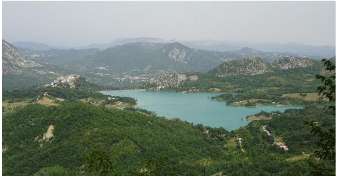
Figura 2-3: Serbatoio di Castel San Vincenzo
