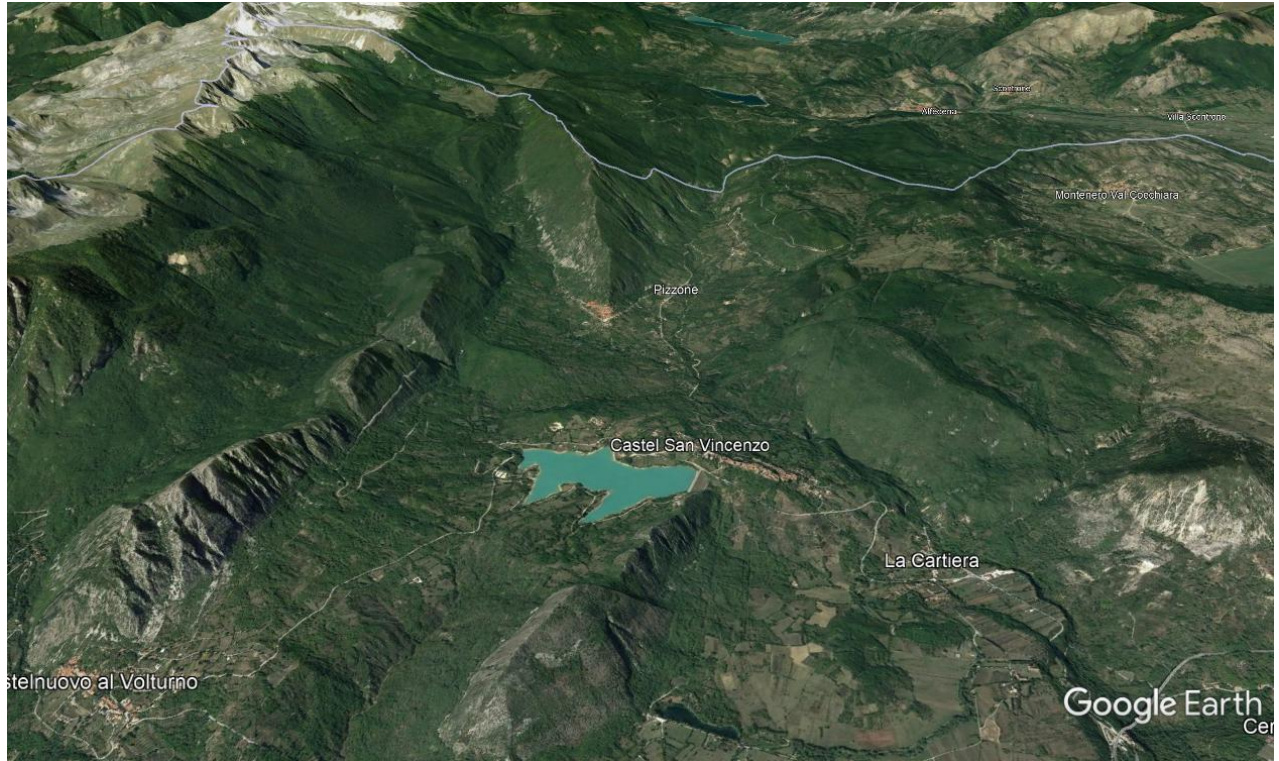
Figura 4-1 - Vista aerea dell'area di intervento tra i laghi di Montagna Spaccata a monte e Castel San Vincenzo, a valle
