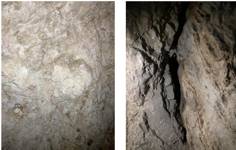
**Figura 6-3: Finestra di ispezione lungo la Condotta Forzata. a) qualità roccia in galleria a monte dell'impianto di pizzone; b) frattura osservata nella stessa galleria**
