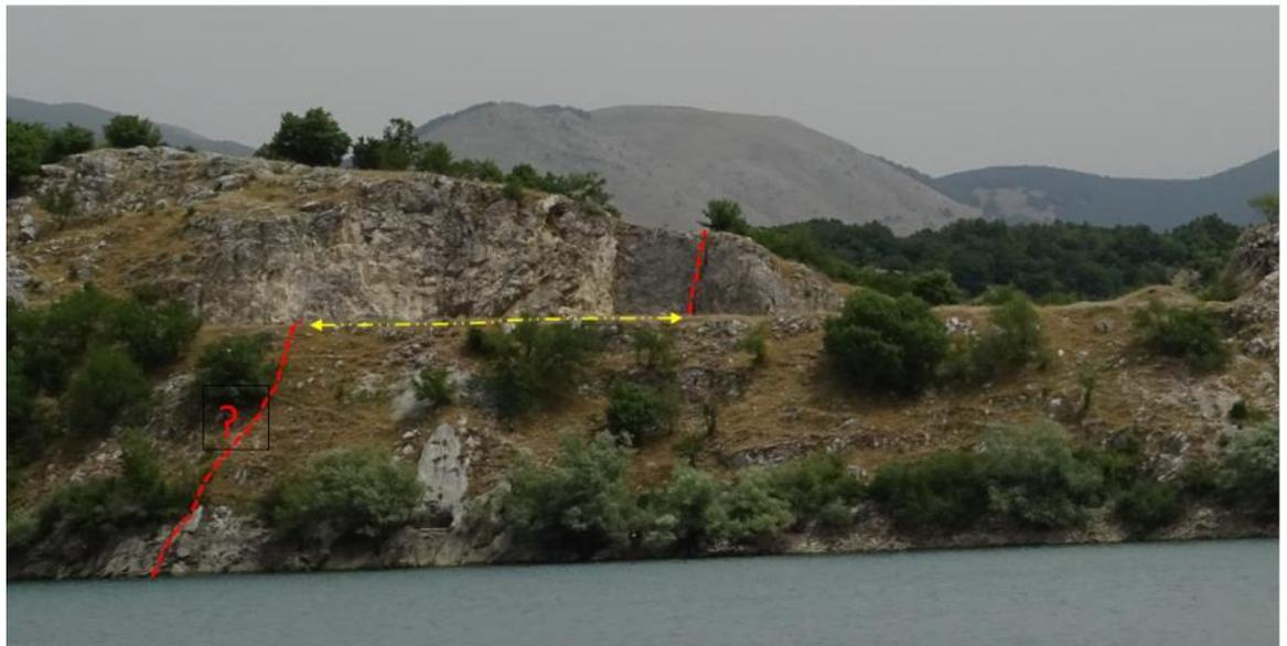
**Figura 6-2 - Invaso di Montagna Spaccata. Vista di dettaglio della precedente foto della spalla sinistra della diga principale. Dalla finestra generata da una cava di prestito dismessa, si nota che il calcare è interessato superficialmente dalla presenza di molte famiglie di giunti. Una frattura molto aperta potrebbe estendersi anche sotto al piano della cava.**
