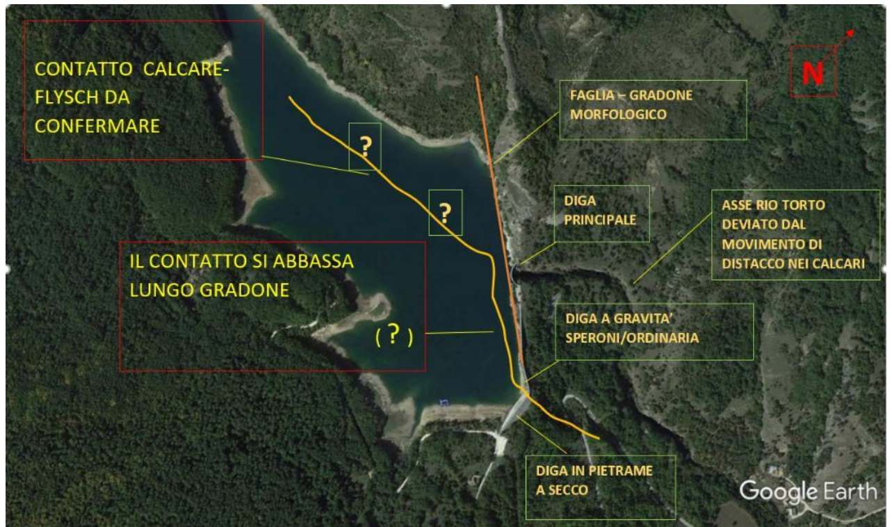
Figura 3-2 - Lago di Montagna Spaccata. Vista aerea con dettaglio sui tratti significativi della geologia in prossimità delle opere
