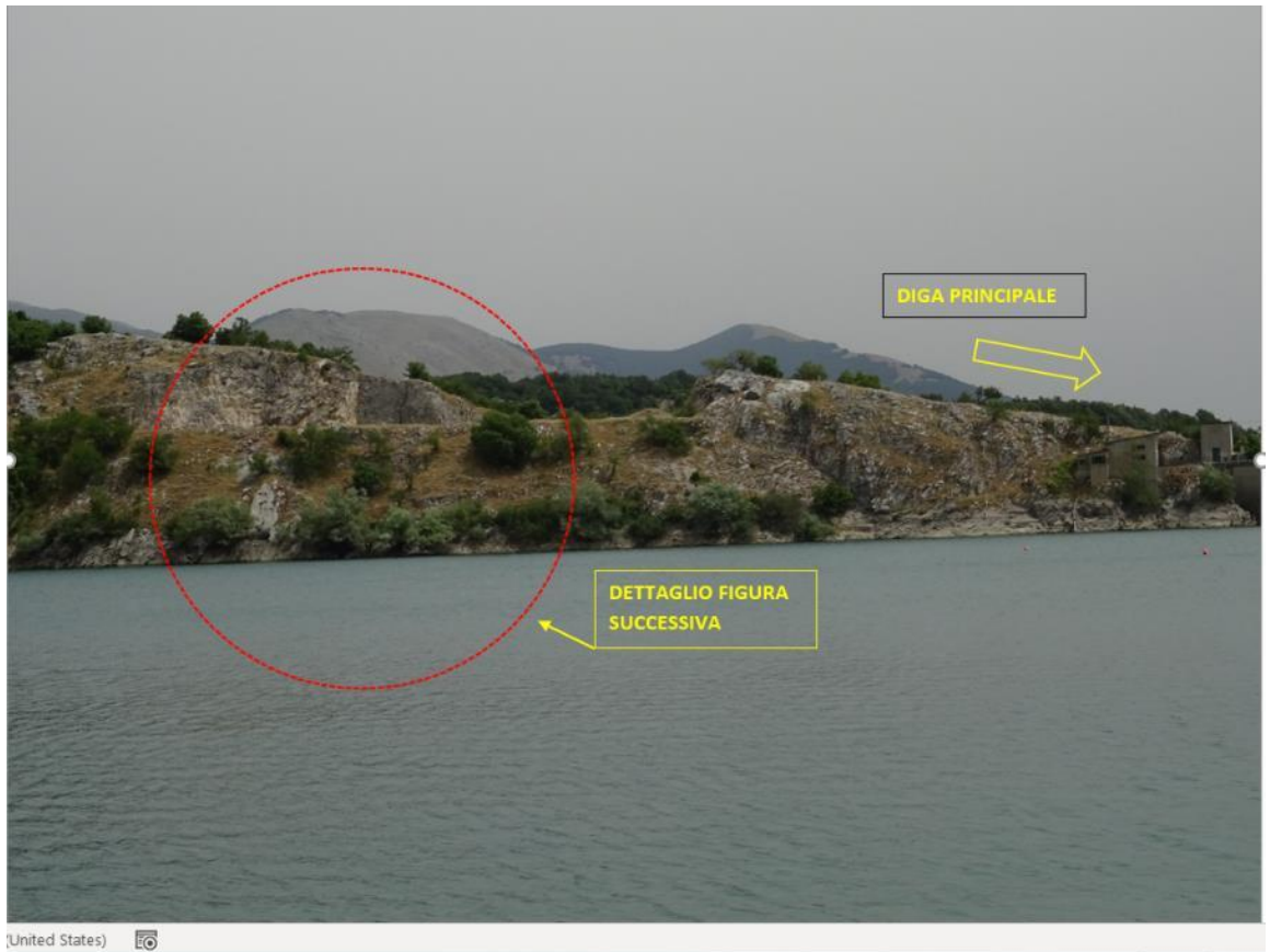
Figura 3-3 - Invaso di Montagna Spaccata. Vista della spalla sinistra della diga principale. Il blocco di calcare miocenico digrada verso la destra
