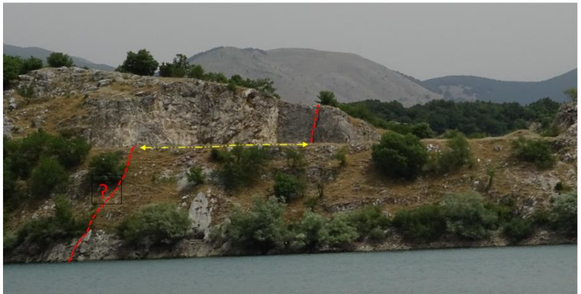
Figura 3-4 - Invaso di Montagna Spaccata. Vista di dettaglio della precedente foto della spalla sinistra della diga principale. Dalla finestra generata da una cava di prestito dismessa, si nota che il calcare è interessato superficialmente dalla presenza di molte famiglie di giunti. Una frattura molto aperta potrebbe estendersi anche sotto al piano della cava.
