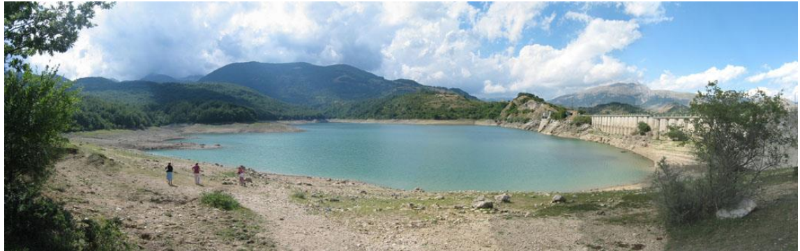
Figura 5-1: Serbatoio di Montagna Spaccata
