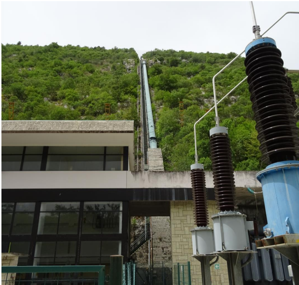
Figura 5-2: Vista della condotta forzata dal piazzale della Centrale di Pizzone
