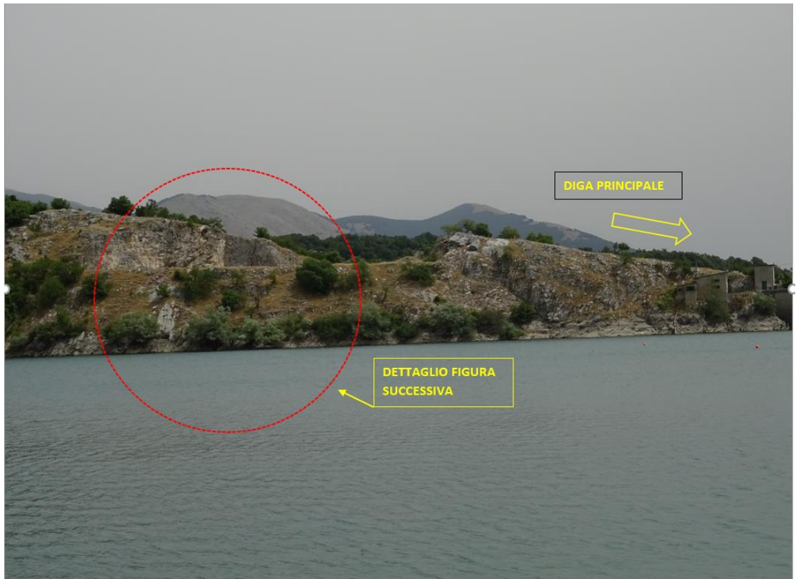
Figura 6-48 - Invaso di Montagna Spaccata. Vista della spalla sinistra della diga principale. Il blocco di calcare miocenico digrada verso la destra
