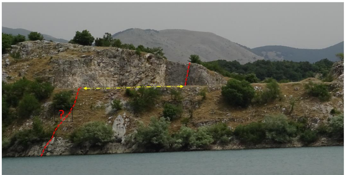
Figura 6-49 - Invaso di Montagna Spaccata. Vista di dettaglio della precedente foto della spalla sinistra della diga principale. Dalla finestra generata da una cava di prestito dismessa, si nota che il calcare è interessato superficialmente dalla presenza di molte famiglie di giunti. Una frattura molto aperta potrebbe estendersi anche sotto al piano della cava
