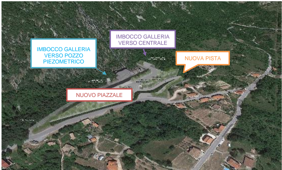
Figura 4-24. Pista di accesso nuovo piazzale della Centrale esistente Pizzone
