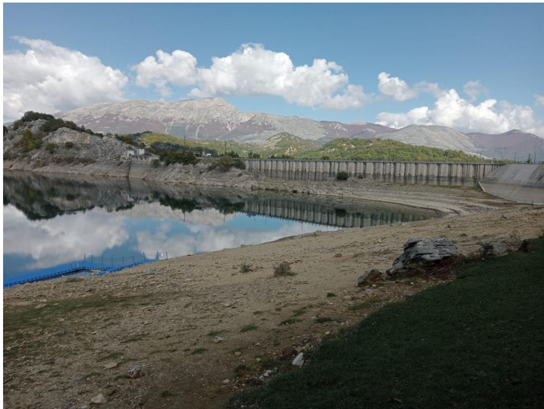
Figura 4-33: diga del lago di Montagna Spaccata
