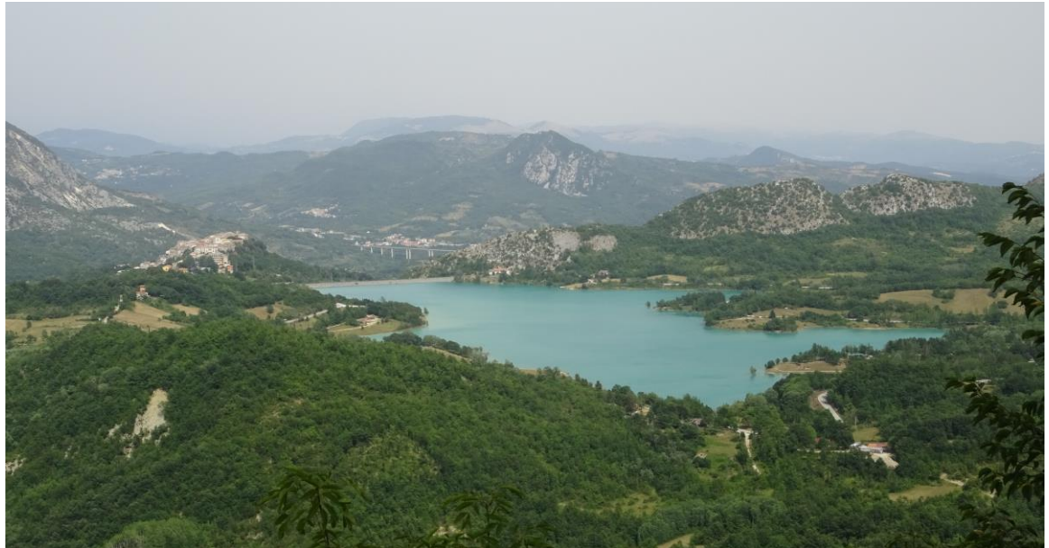
Figura 2-2: Serbatoio di Castel San Vincenzo
