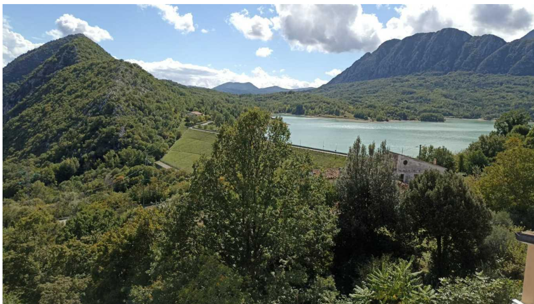
Figura 3-5: La diga, il lago artificiale di Castel San Vincenzo
