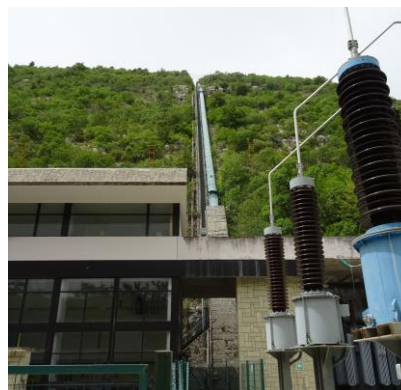
Figura 3-3: Vista della condotta forzata dal piazzale della Centrale di Pizzone
