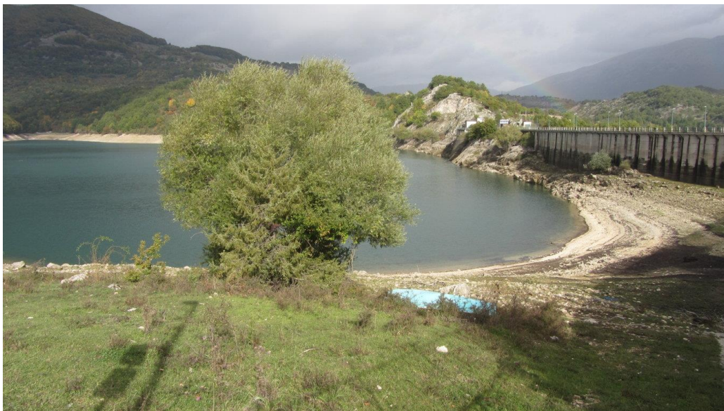
Figura 3-2: Serbatoio di Montagna Spaccata in prossimità delle aree di cantere
